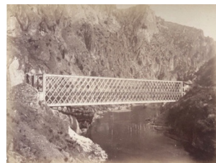
VI.6 Puente sobre el rio Sil en el estrecho de Cobas, 1883 Albumina, 10x15 (16x25) cm
