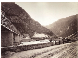
II.7 Veduta di un tratto di linea fra il ponte sul Fella e l'imbocco della 2° Galleria Ponteperaria, giugno 1878 Albumina, 24x36 (30x50) cm
