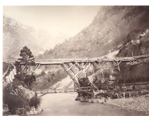
III.11 Ponte provvisorio di servizio sul Fella = a carreggiata = allacciante la strada nazionale alla ferrovia, giugno 1879 Albumina, 24x32 (35x47) cm
