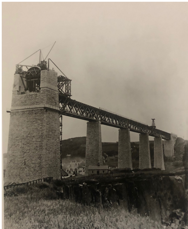
Fig.6 Evelyn George Carey, North approach, viaduct spans , 6 July 1888, stampa positiva contemporanea da negativo originale su lastra di vetro n. 274. Negativo originale conservato presso il National Archives of Scotland di Edimburgo, 6x9 cm.
