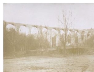
XX.6 Ponte viadotto sul fiume Olona , [ante 1894] Albumina, 18x24 (30x40) cm
