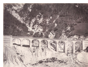
III.12 Ponte-viadotto sul Rio Costa da Presa, giugno 1879 Albumina, 24x32 (35x47) cm
