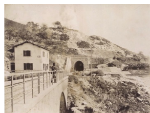
XIII.20 Galleria Santa Barbara imbocco Eboli, [post 1891-ante 1893] Albumina, 23x27 (45x35) cm
