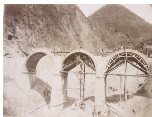
XI.5 Viadotto di Grondola (in costruzione), [1894] Albumina, 24x36 (35x51) cm
