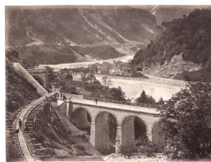
III.15 Ponte-Viadotto sul Rio Chiout-Martin, giugno 1879 Albumina, 24x32 (35x47) cm
