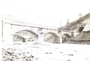
XIX.17 Ponte obliquo sul torrente Stura (2° attraversamento), 1894 Albumina, 18x24 (25x30) cm
