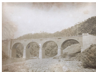
XIX.22 Ponte sul torrente Stura (5° attraversamento), 1894 Albumina, 18x24 (25x30) cm
