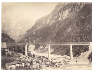
III.17 Ponte-viadotto sul torrente Dogna, giugno 1879 Albumina, 24x32 (35x47) cm
