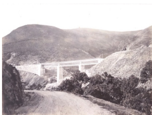
VII.20 Viaducto sobre el barranco Villufre (k. 346), 1883 Albumina 18x24 (30x40) cm
