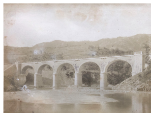
XIX.23 Ponte sul torrente Stura (4° attraversamento), 1894 Albumina, 18x24 (25x30) cm
