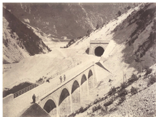
III.22 Viadotto del Pero all'imbocco della galleria di Cadramazzo, giugno 1879 Albumina, 24x32 (35x47) cm
