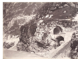
III.3 Imbocco della galleria di Chiassaforte, giugno 1879 Albumina, 24x32 (35x47) cm
