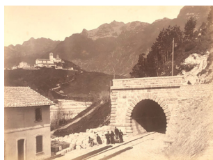
I.4 Imbocco galleria di Moggio, [1877] Albumina, 24x32 (32x45) cm
