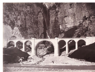
III.20 Ponte-viadotto sul Rio Cadramazzo, giugno 1879 Albumina, 24x32 (35x47) cm
