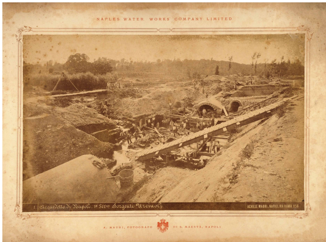
Fig.69 Achille Mauri, Acquedotto di Napoli. 1° sez.ne Sorgenti Urciuoli , [1882-1885] stampa positiva all'albumina 18x24 contenuta nell'album Naples Water Works Company Limited . Biblioteca Reale di Torino.
