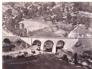
VII.14 Puente y viaducto sobre el rio soldon (k. 327), 1883 Albumina 18x24 (30x40) cm
