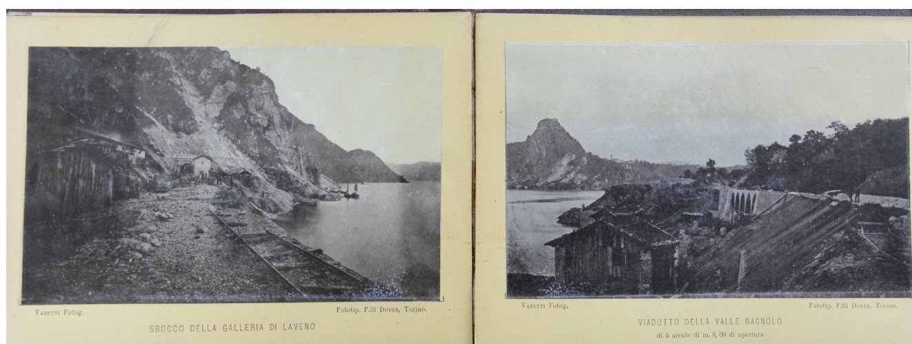
Fig. 50 Vanetti-F.lli Doyen, Sbocco della Galleria di Laveno, Viadotto della Valle del Bagnolo , fototipie contenute nell'album Ferrovia Novara-Pino , 1882
