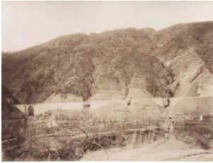
XI.12 Muro di sostegno fra la Cialastra e la Galleria del Bronzino, [1894] Albumina, 24x36 (35x51) cm
