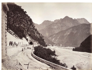
II.4 Imbocco della Galleria Ponteperaria, giugno 1878 Albumina, 24x36 (30x50) cm
