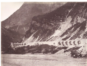
III.23 Viadotto di Prato. Viadotto dei Vidali, giugno 1879 Albumina, 24x32 (35x47) cm
