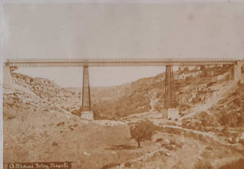
Ferrovia Bari-Taranto. Viadotto di Palagianello.
