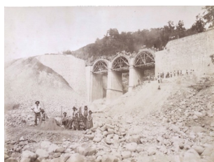
XI.2 Viadotto di Guinadi (in costruzione), [1894] Albumina, 24x36 (35x51) cm
