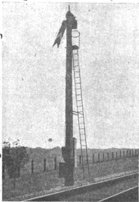
Fig. 1. - Semaforo manovrato con batteria a distanza.
