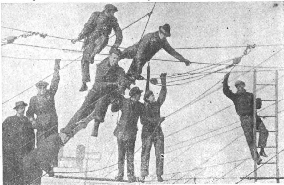
Fig. 5 - Montaggio delle condutture di contatto.
