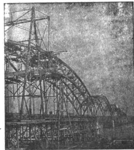
Ponte sul PO alla Gerola (Voghera) lung. m. 751,56. 8 arcate. Fondazioni ad aria compressa.
