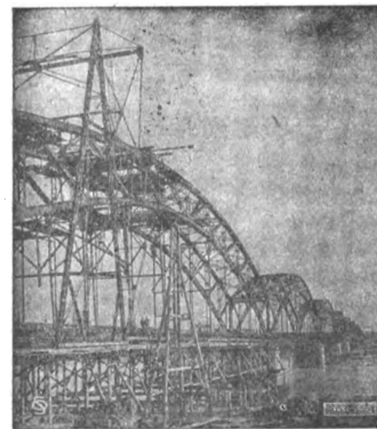
Ponte sul PO alla Gerola (Voghera) lung. m. 751,56. 8 arcate. Fondazioni ad aria compressa.
