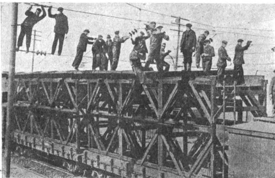
Fig. 3 - Montaggio delle condutture di contatto.
