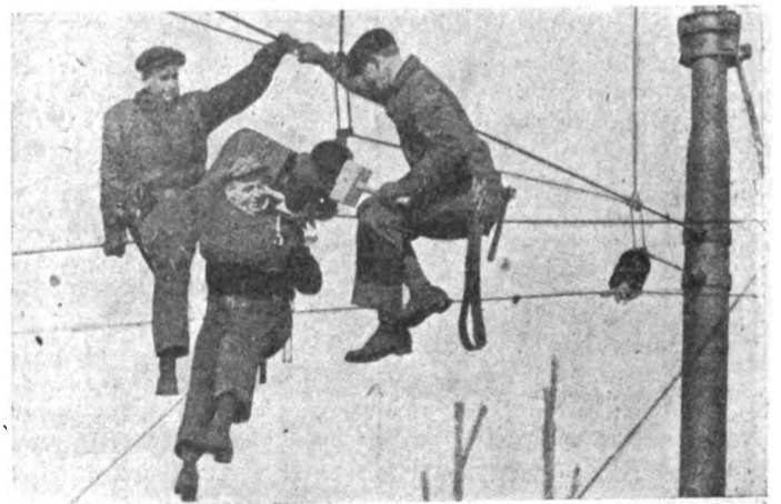
Fig. 4 - Montaggio delle condutture di contatto.
