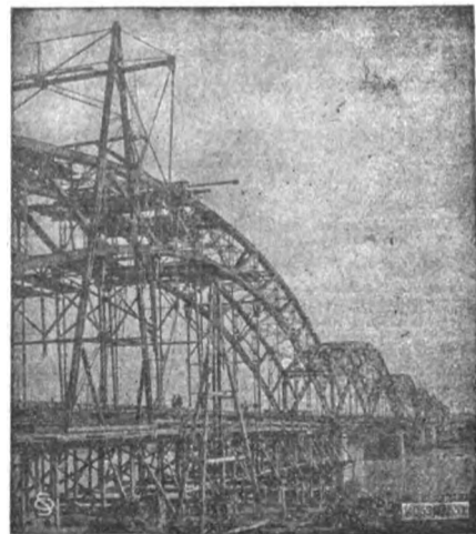
Ponte sul PO alla Gerbia (Voghera) lung. m. 751,56. 8 arcate. Fondazioni ad aria compressa.
