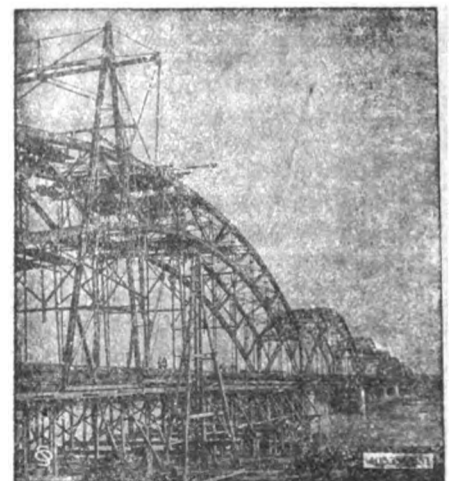
Ponte sul FO alla Gerola (Voghera) lung. m. 751,56. 8 arcate. Fondazioni ad aria compressa.
