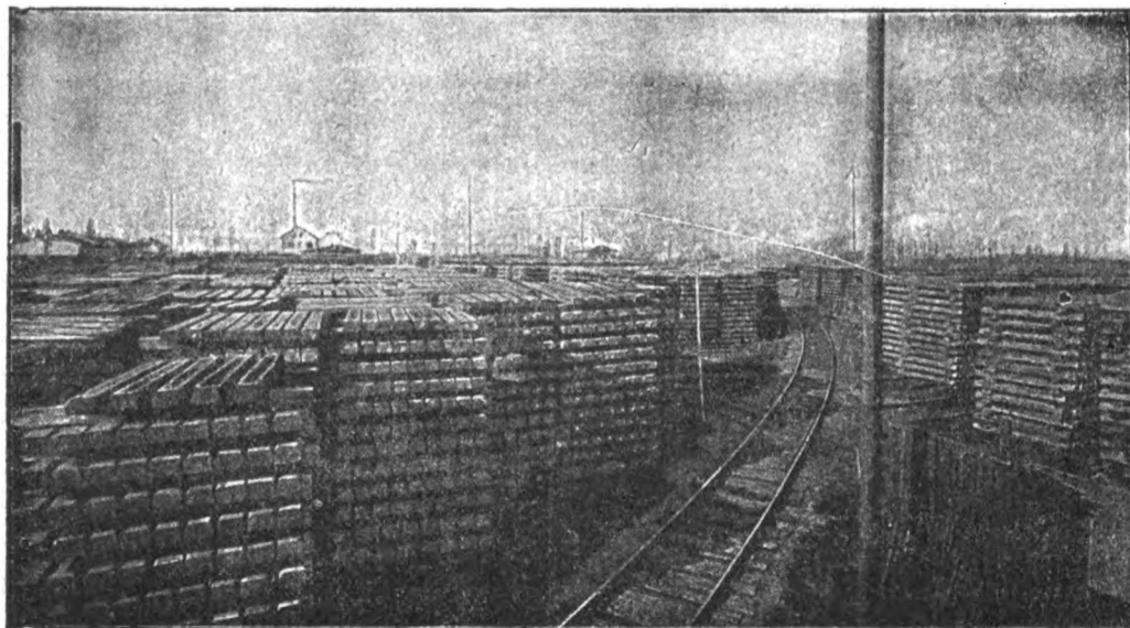
Stabilimento d'iniezione con olio di catrame di Spira s. Reno. (Cantiere e deposito delle traverse).
