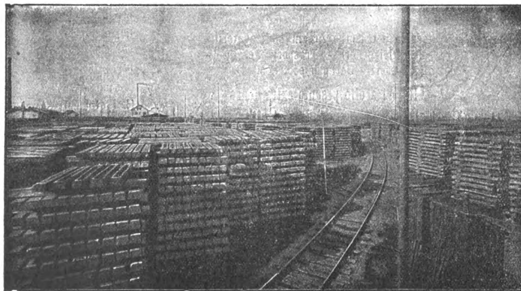
Stabilimento d'iniezione con olio di catrame di Spira s. Reno. (Cantiere e deposito delle traverse).
