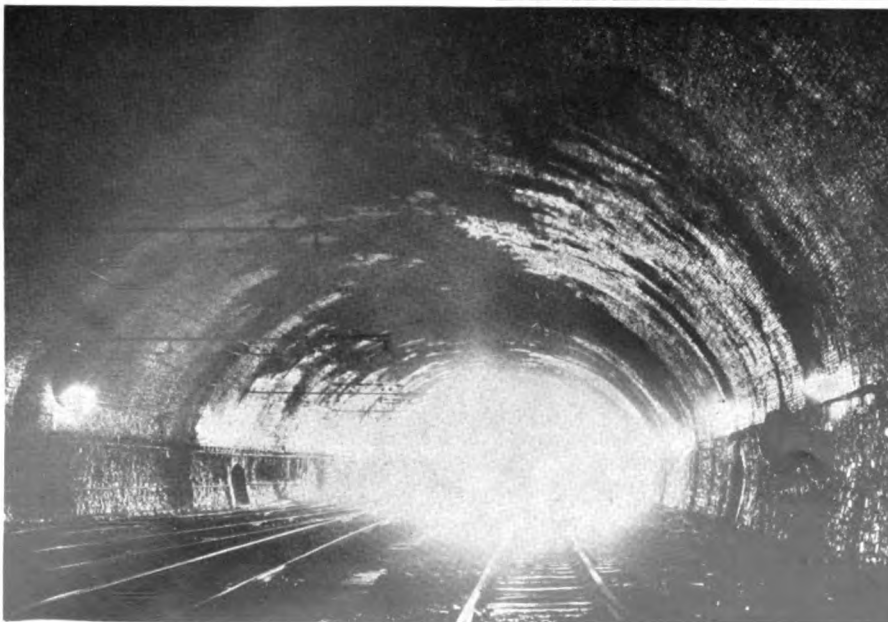
Interno d'una camera di biforcazione della galleria « Traversata ».
