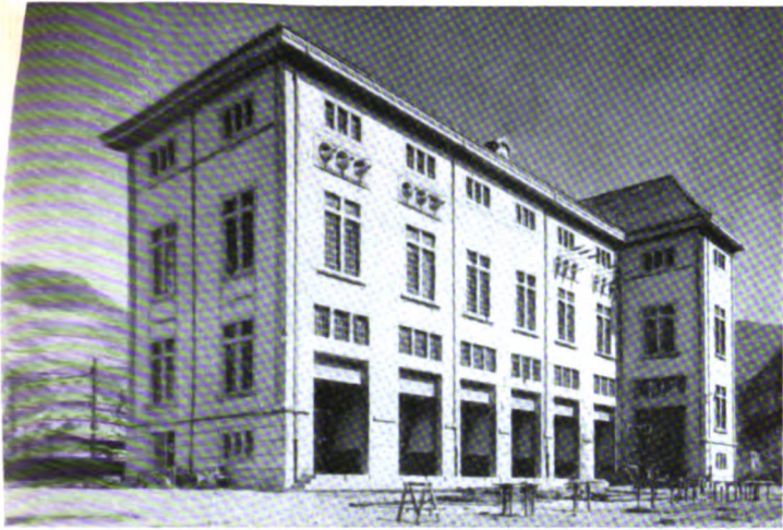
La S.S.E. di Bolzano (1929).
