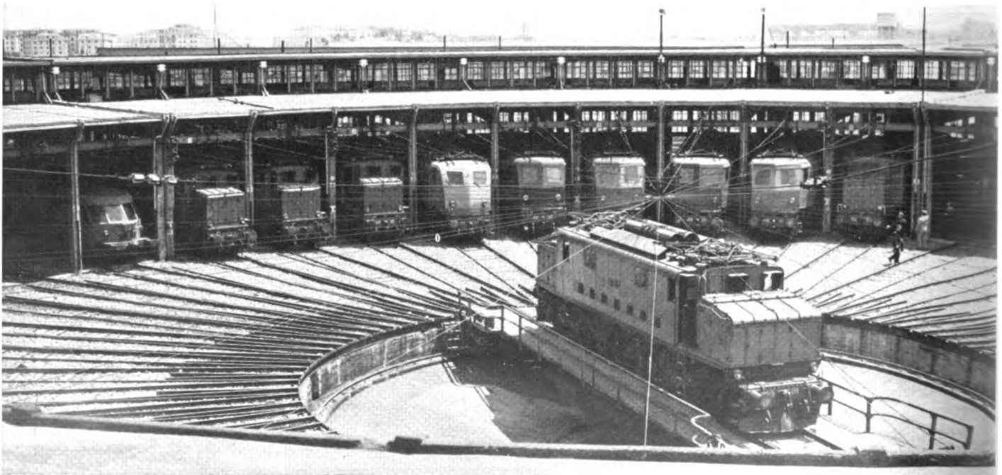
La rimessa del Deposito Locomotive di Roma S. Lorenzo.
