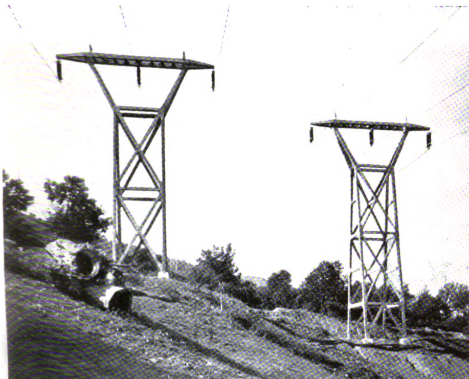
Doppia terna su palificazione separata, in cemento armato, Suviana-Ca' di Landino (1940).
