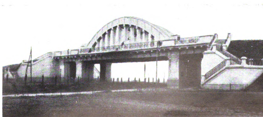
Cavalcavia di Rogoredo (linea Milano-Bologna) con travi principali ad arco a spinta eliminata, della luce di m 34,70 sull'obliquo.
