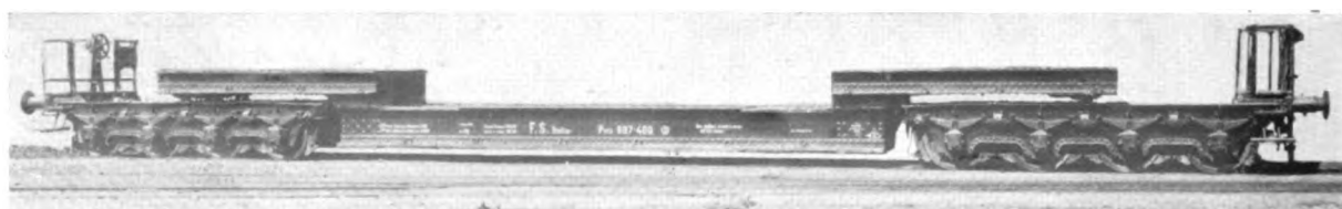
Carro tipo 1932 per carichi voluminosi - Portata t 40 - Tara t 51.
