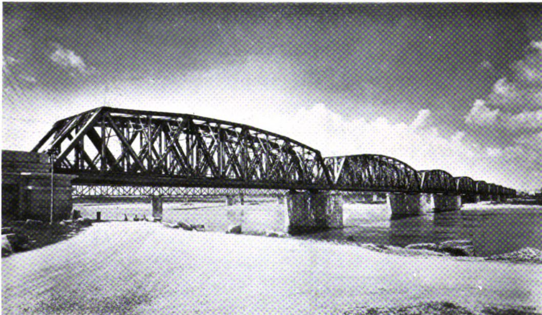
Ponte sul Po a Piacenza (linea Bologna-Milano) a travate indipendenti, con travi maestre a grandi maglie triangolari ed a profilo superiore semiparabolico, a passaggio inferiore, chiuse superiormente. Lunghezza complessiva dell'opera m 764, su 11 luci.
