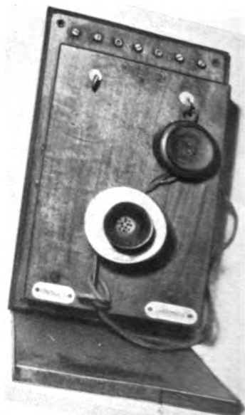
Apparecchio telefonico da muro a batteria locale, tipo Kellog.
