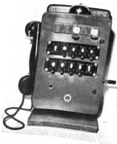
Centralino telefonico manuale a batteria locale con 5 linee.
