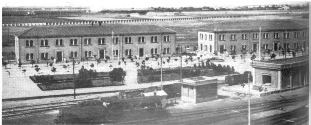
Uffici e dormitori dello stesso Deposito di Foggia.
