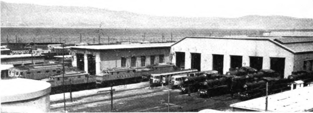
Il Deposito Locomotive di Reggio Calabria.
