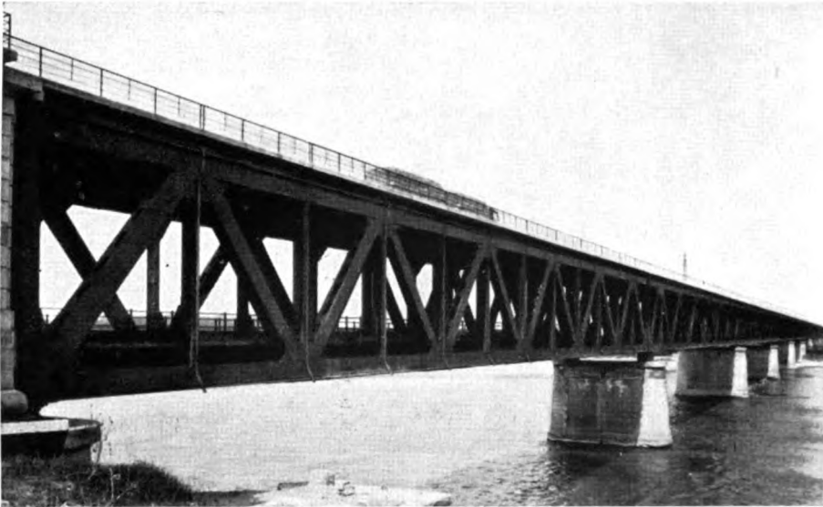
Ponte promiscuo sul Po a Mezzanacorti (linea Milano-Genova) a 10 travate indipendenti, chiuse, a grandi maglie triangolari, a passaggio inferiore ferroviario e passaggio superiore stradale, della portata di m 75 ciascuna.
