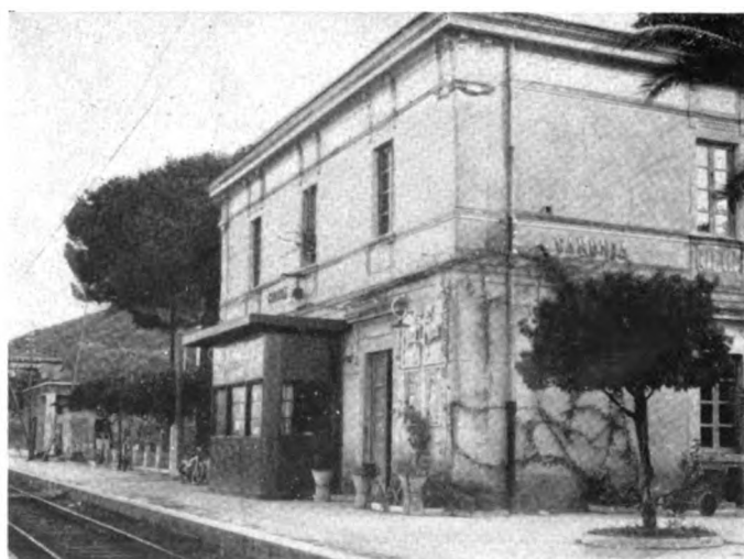
Cabina addossata per apparati centrali elettrici.
