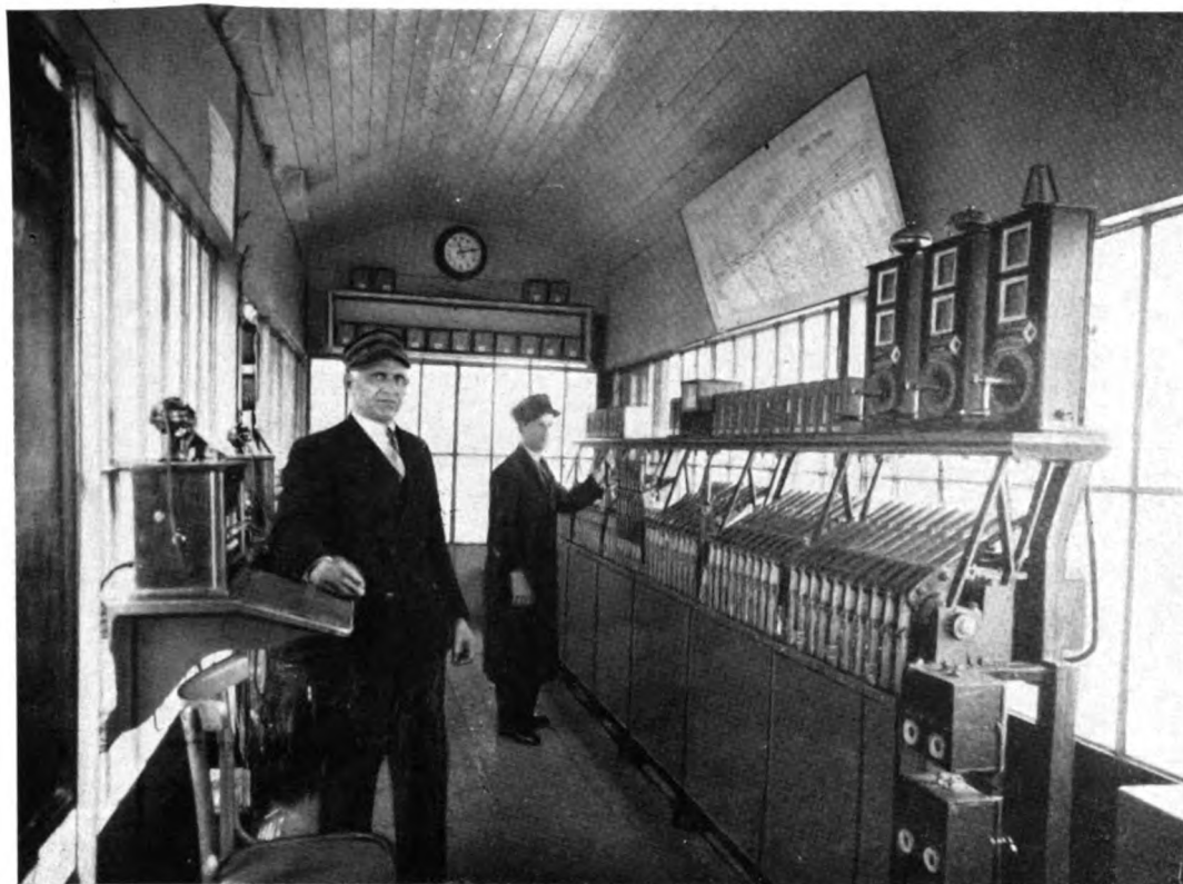
Interno di cabina idrodinamica.
