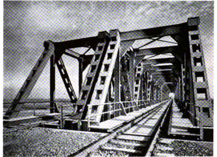
Ponte sul Reno a Poggiorenatico (linea Bologna-Padova) a 3 campate di m 43,36-49,76-43,25, con travi maestre a grandi maglie triangolari, a passaggio inferiore, chiuse superiormente.
