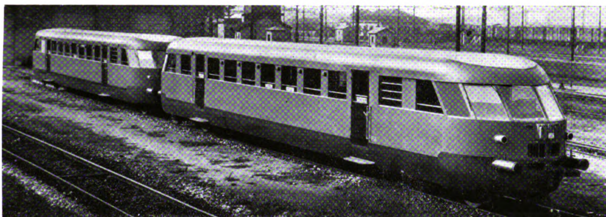
Automotrice Gr. ALn 556 - 2 motori Diesel veloci (accoppiabili) - Potenza cav 260 - Velocità massima km/h 140 - Peso in servizio t 26,4 - Posti II 16 - III 40 - i. p. 20 - Anno di costruzione 1938 (BREDA).
