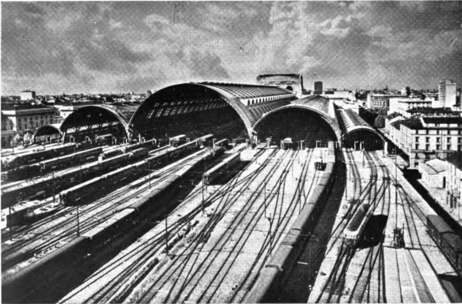
Le coperture di Milano Centrale viste dal lato campagna.
