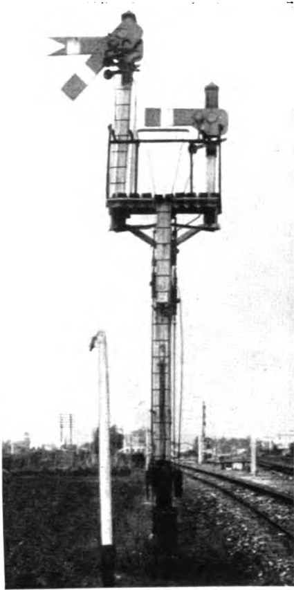
Segnale semaforico di 1ª categoria a candelieri con ala di avviso accoppiata all'ala alta.
