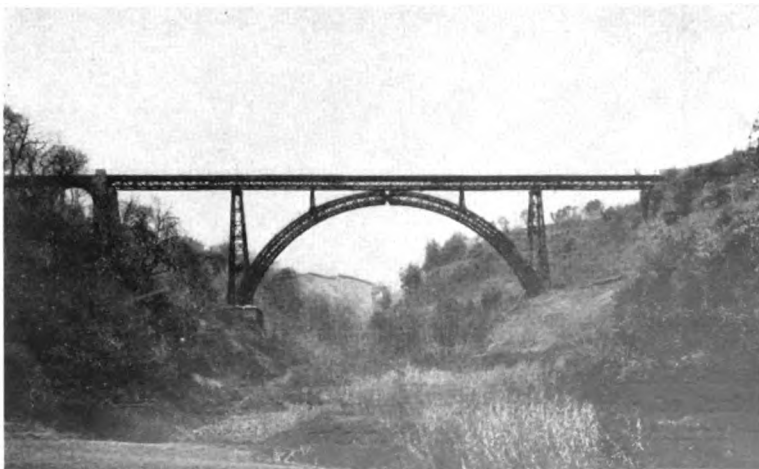
Ponte sul Rio Vicano presso Ronciglione (linea Orte-Civitavecchia) con arco parabolico a 3 cerniere, di 119 metri di luce.
