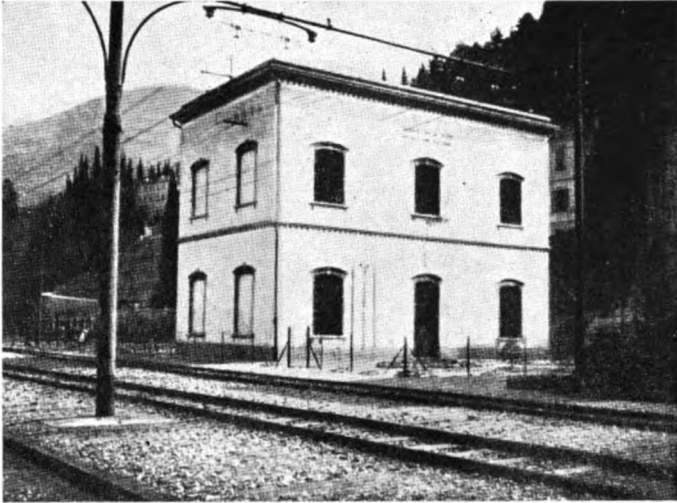
Fabbricato della vecchia S.S.E. di Bellano (1903).
