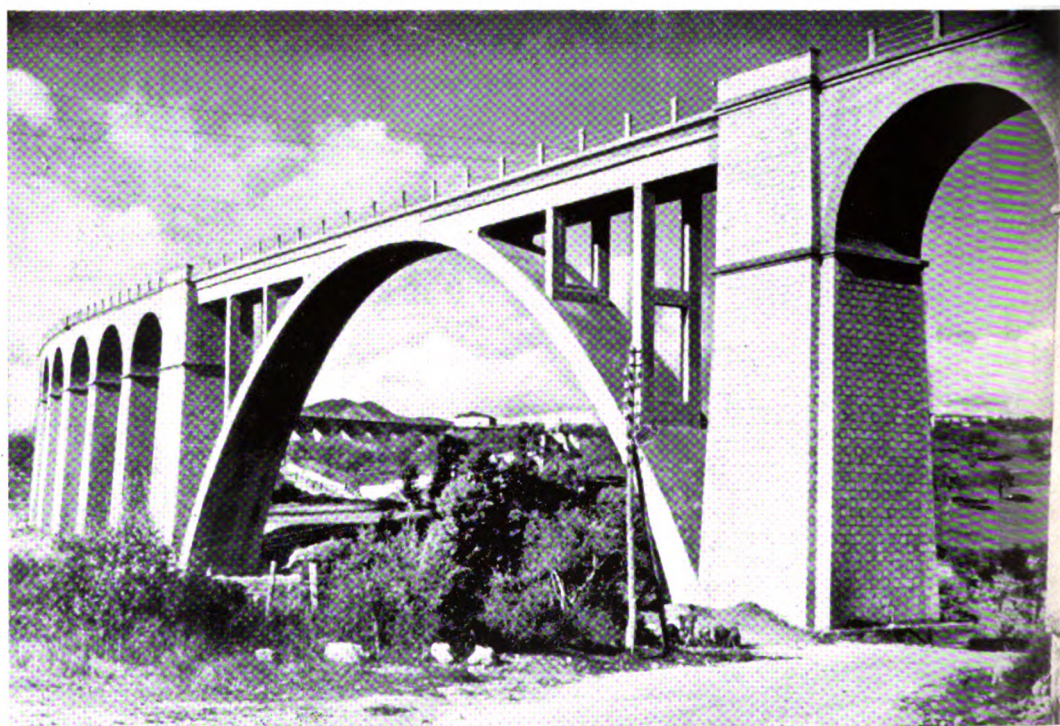
Arcata centrale del Viadotto di S. Spirito (linea Vairano-Campobasso) di m 64,70 di luce, con timpani a giorno, alta m 80 sul fondo valle.
