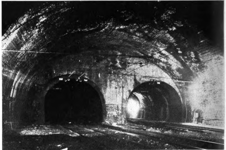
Sbocco dei due fori della stessa galleria nella camera di biforcazione lato Genova Brignole.
