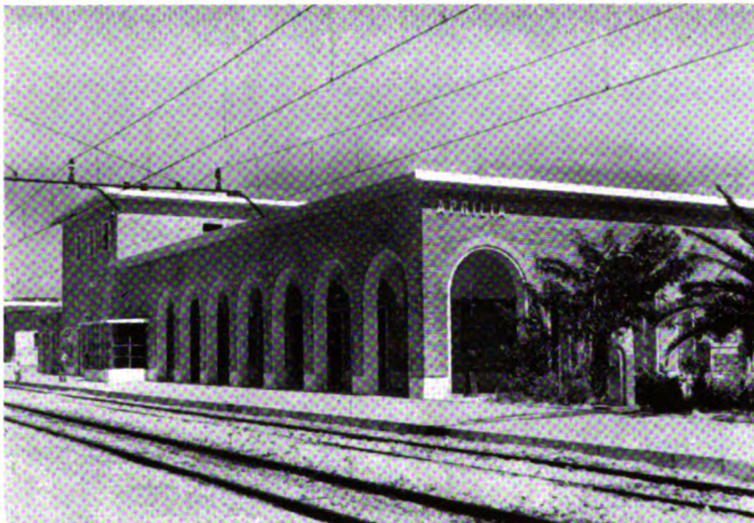
Aprilia (costruzione 1937 – ricostruzione 1951).
