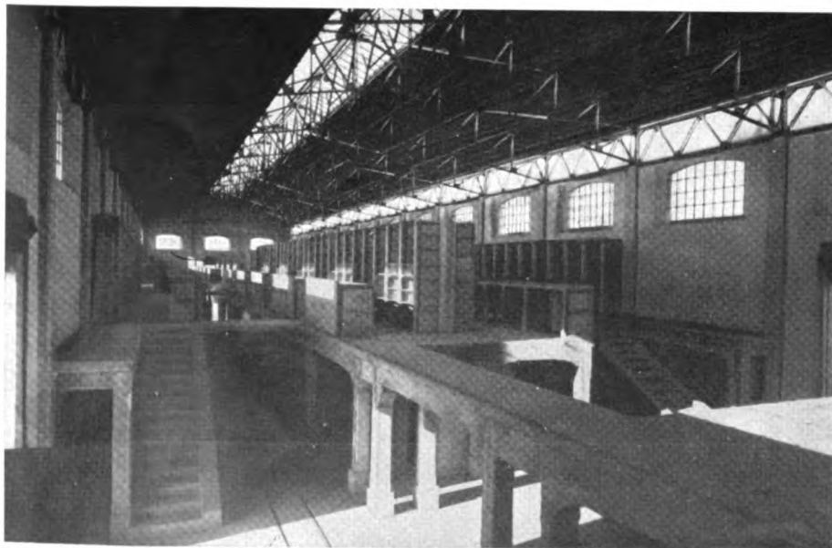
Interno del Magazzino Approvvigionamenti di Cagliari.
