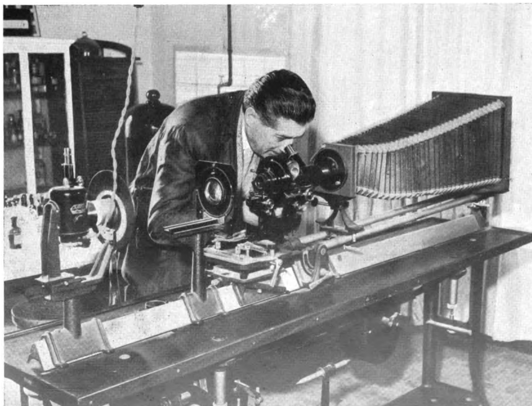
Laboratorio legnami - Apparecchio per esa- mi istologici.
