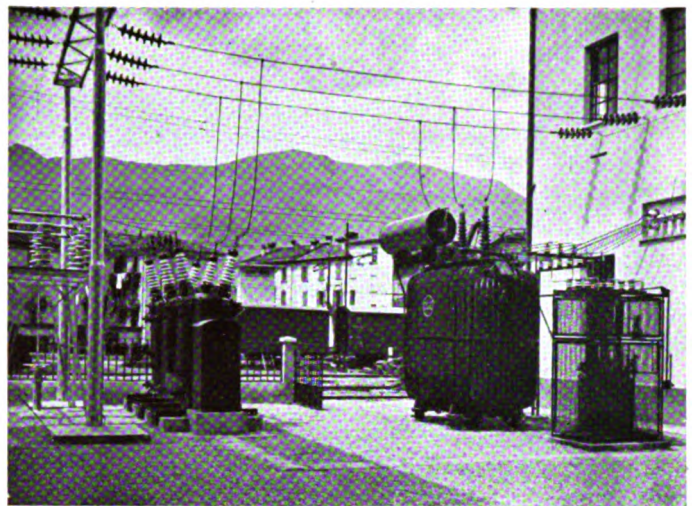
Portali di amarro e sezionatori delle primarie (a sinistra) e interruttore primario e trasformatori di potenza (a destra) della nuova S. S. E. di Bellano (1953).
