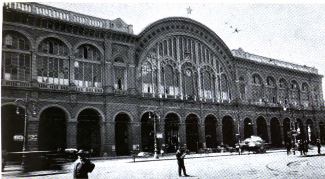
Torino Porta Nuova che ha mantenuto il pregevole prospetto originario anche dopo gli ultimi radicali lavori di ammodernamento eseguiti nel 1953.
