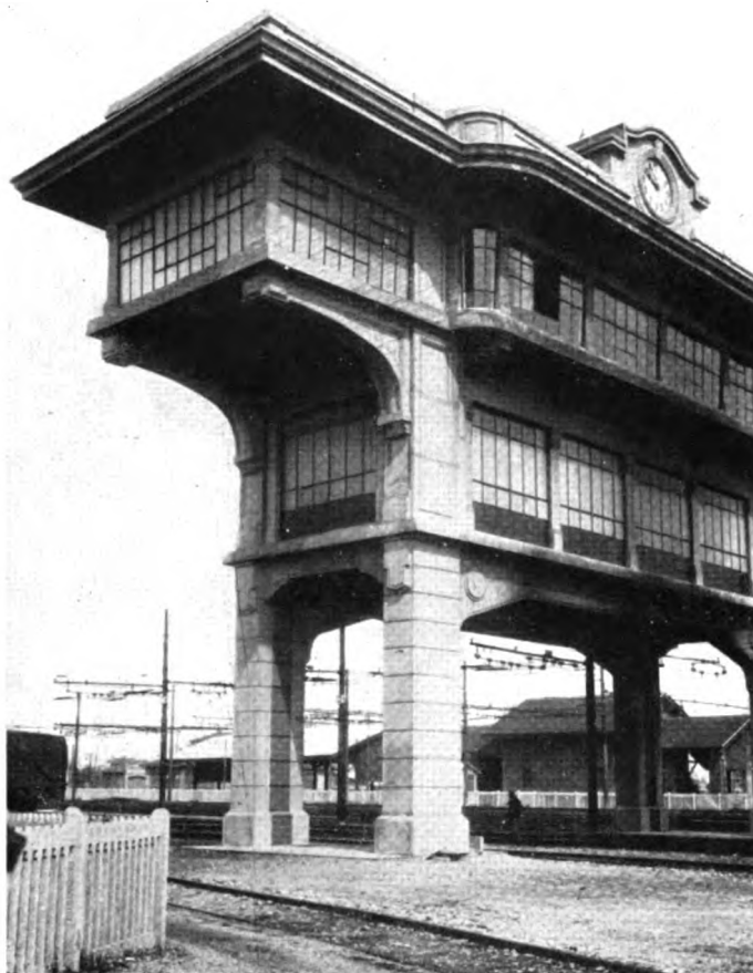
Cabina a portale per apparati centrali elettrici.
