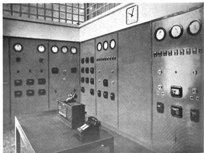
Raddrizzatori a vapori di mercurio e sala quadri della nuova S.S.E. di Morbegno (1953).
