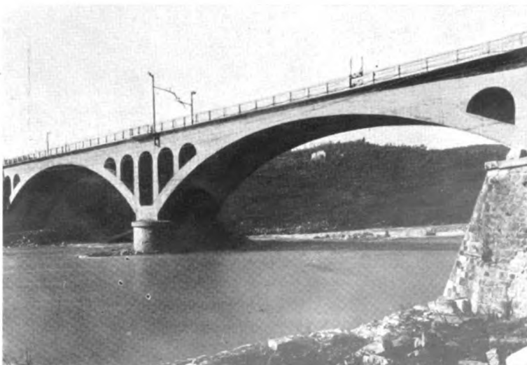
Ponte sull'Arno presso S. Ellero (linea Chiusi-Firenze) a 2 luci di m 44 ciascuna.
