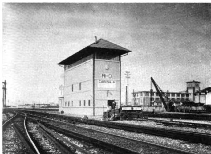
Cabina isolata per apparati centrali elettrici.
