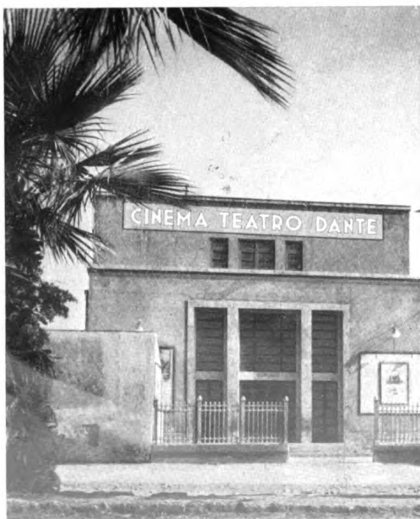
Ingresso del cinema-teatro del Dopolavoro di Palermo.
