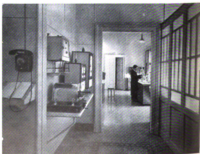
Ancora apparecchi del gabinetto di analisi chimica.
