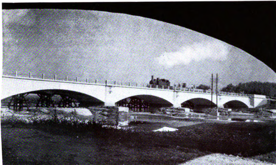
Ponte sull'Orco presso Chivasso (linea Milano-Torino) a struttura cellulare, a 5 archi di m 24,20 di luce, fortemente ribassati (1/10).
