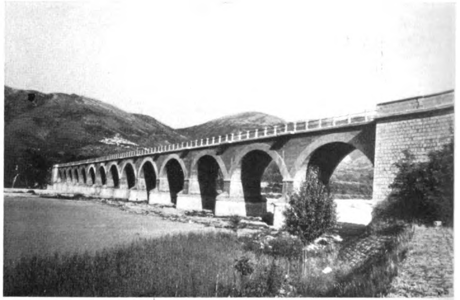
Ponte sul Volturmo (linea Vairano-Isernia) a 14 archi ribassati (1/4), di m 16,25 di luce.
