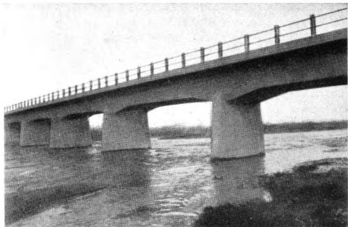
Ponte sul fiume Foro (linea Ancona-Foggia) con impalcature a 3 nervature portanti, a 5 luci di m 14 ciascuna, solidali alle 4 pile intermedie.
