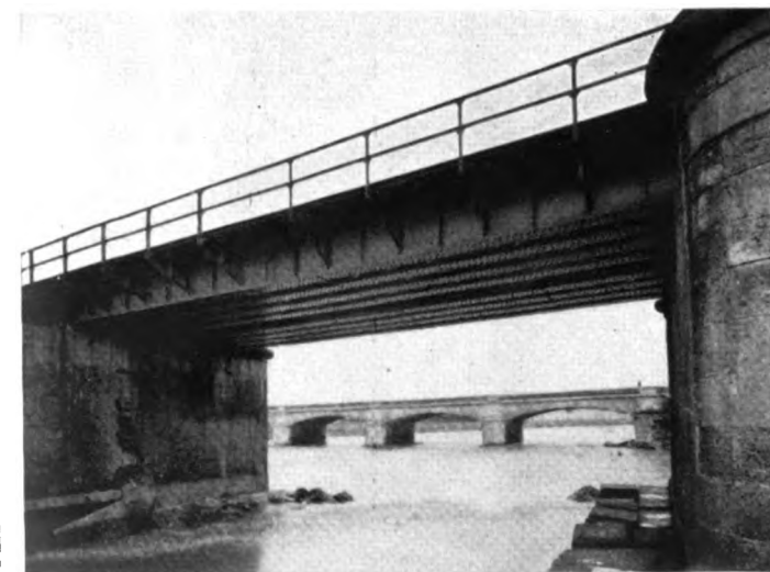
Ponte sullo Stura (linea Torino-Milano) a sei luci, del tipo a travi gemelle, della lunghezza totale di m 99,50.
