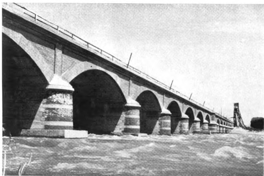
Ponte promiscuo, per strada e ferro- via, sul Po a Torreberetti (linea Alessandria-Novara), a 21 luci di m 20 ciascuna.
