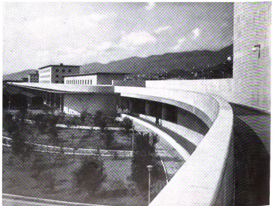
Il collegamento fra Messina Centrale e Messina Marittima.
