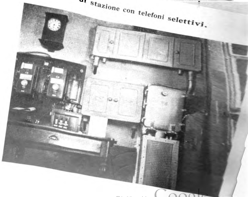
Telefono selettivo con cassetta stagna, inseribile su due circuiti.
