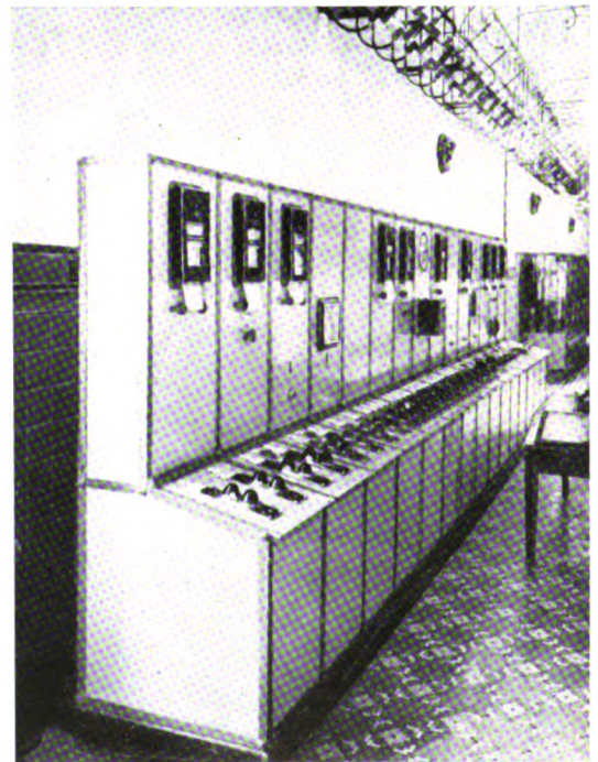
Sala interruttori tipo F. S. da 4 kV e quadro dei comandi della stessa S.S.E. di Sampierdarena.
