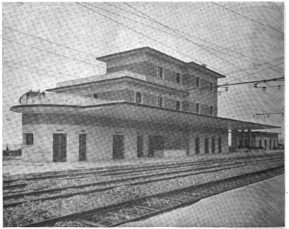
Prospetto verso i binari.
