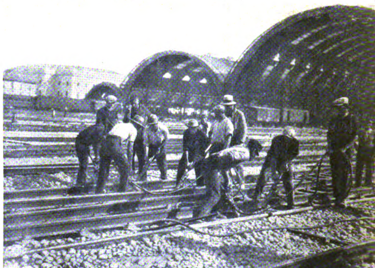
Lavori di rinalzata rotaie con martelli pneumatici
