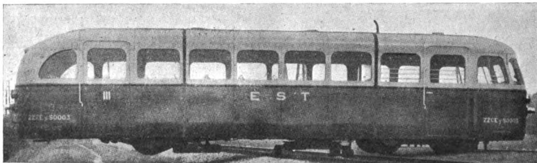
FIG. 1. — Automotrice leggera della Compagnia dell'Est francese, munita inferiormente di piattaforma girevole trasportata dalla vettura stessa.
