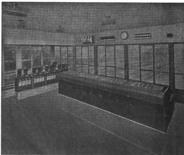
Apparato centrale elettrico a 4 ordini di leve per manovre scambi e segnali
