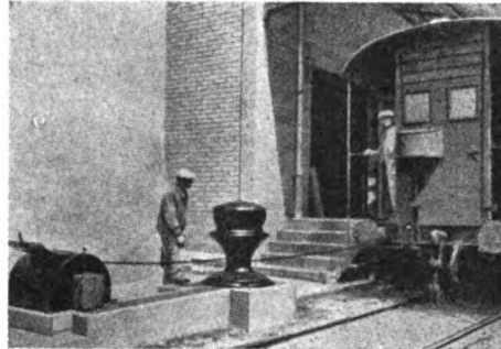
Fig. 2. — Arganello ad azionamento a pedale, combinato con il tamburo d'avvolgimento automatico della fune.
