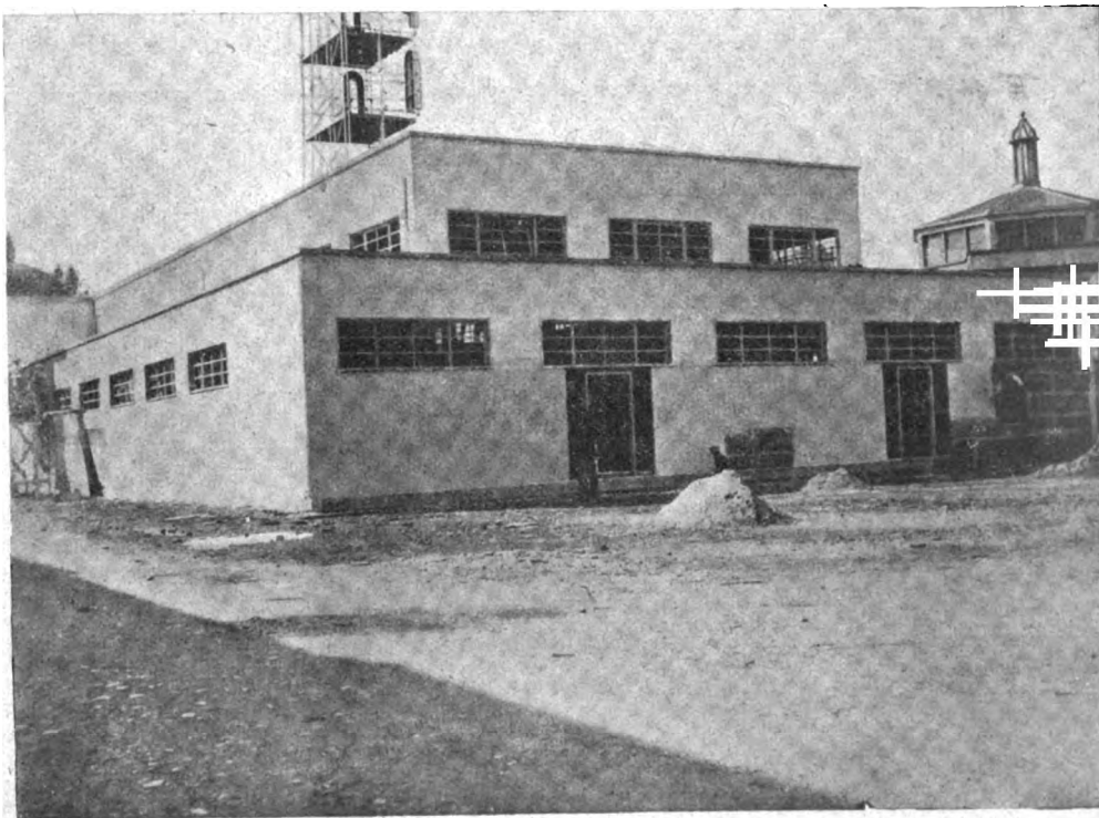
Il Padiglione della U. N. P. A. (Unione Nazionale Protezione Antiaerea) alla FIERA di MILANO 1936, costruito con "POPULIT"
