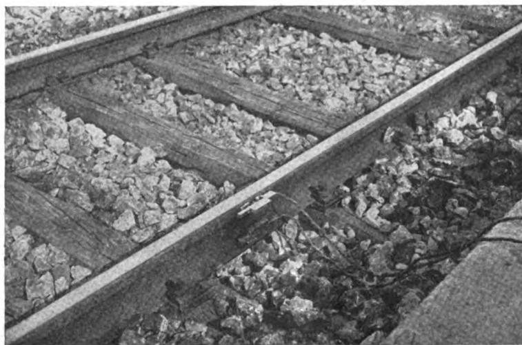
FIG. 22. — Applicazione di rivelatori Peters ad una rotaia.
