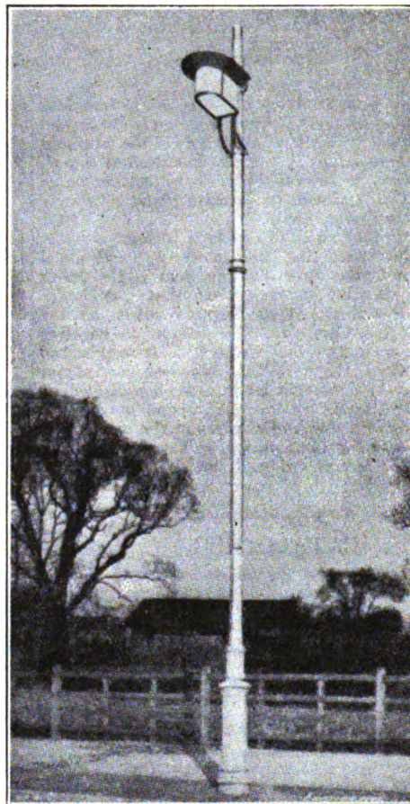
Fig. 4. — Apparecchio di illuminazione con lampada Ozira adottato a Wembley.
