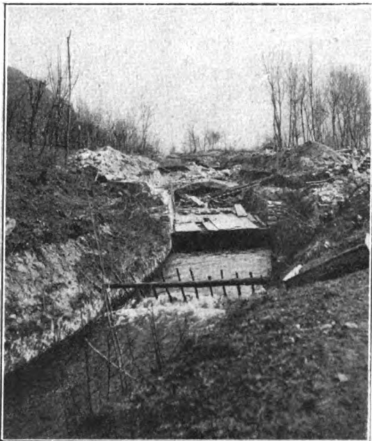
FIG. 15. — Imbocco a valle galleria artificiale Thoà.
