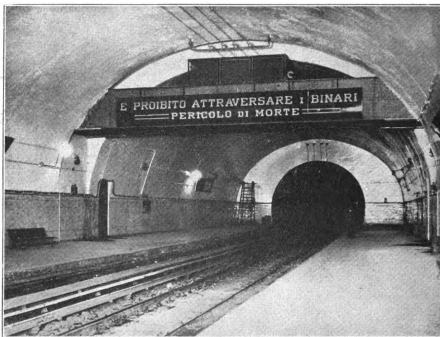
FIG. 3. — Direttissima Roma-Napoli. Fermata sotterranea di Piazza Amedeo in Napoli: La fermata a lavori ultimati.
