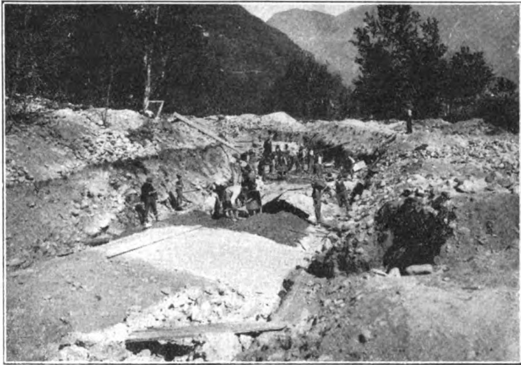
FIG. 14. — Rialzo calotta galleria artificiale Thoà.
