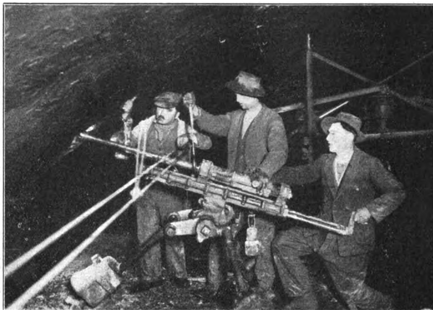
FIG. 6. — Ferrovia Domodossola-Iselle: Esecuzione di un foro per drenaggio nella volta di una galleria con perforatrice Ingersol. A destra, dietro l'operaio che manovra la perforatrice, si vede l'attrezzatura per la sospensione degli isolatori al centro della galleria.
