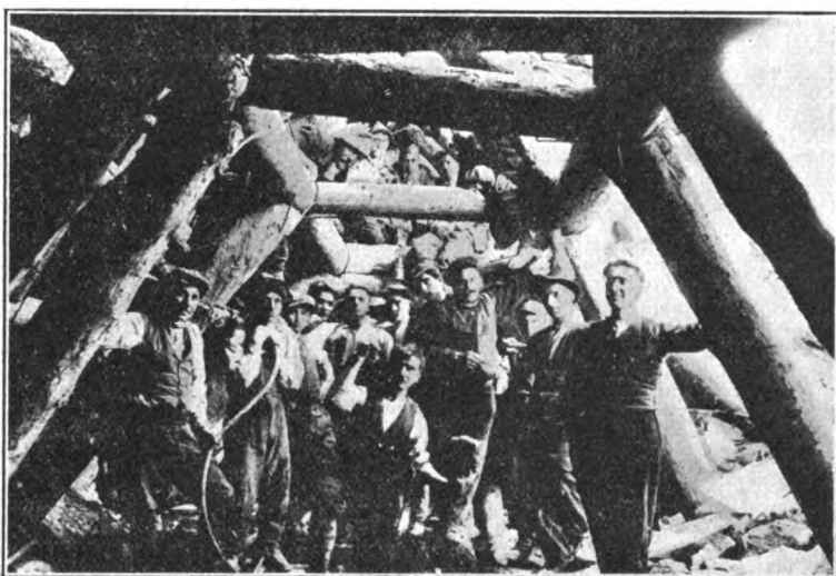
FIG. 4. — Armature usate nel rialzo delle gallerie.
