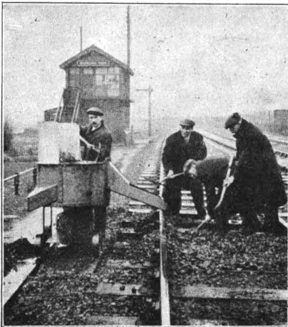
Macchina per la pulizia della massicciata.
