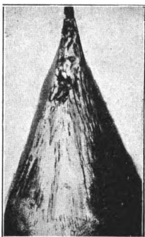
FIG. 1. — Punta di spina di turbina idraulica erosa e corrosa per aereazione differenziale.
