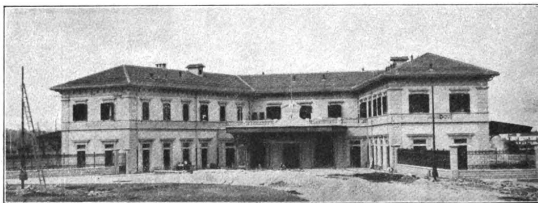
FIG. 8. — Nuova stazione di Mondovì. Fabbricato viaggiatori.
