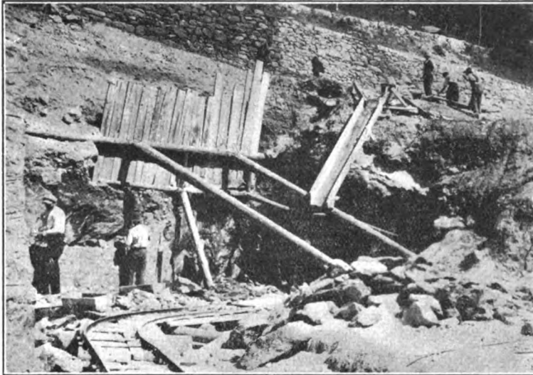
FIG. 6. — Rialzo volto galleria del Ponte.
