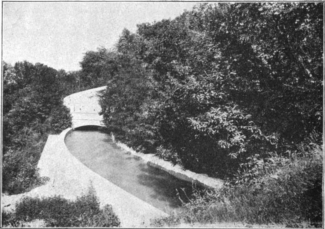
FIG. 17. — Canale derivatore Impianto Morbegno fra le gallerie dei Torchi.
