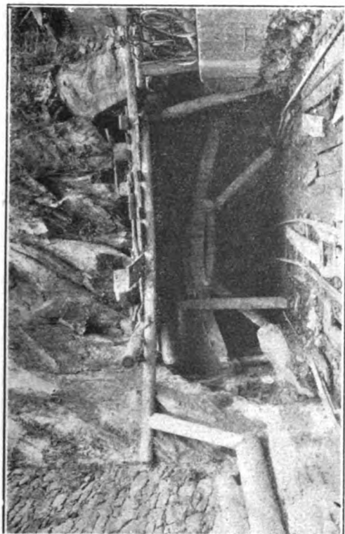
Fig. 12. — Imbocco a valle galleria Campovico.
