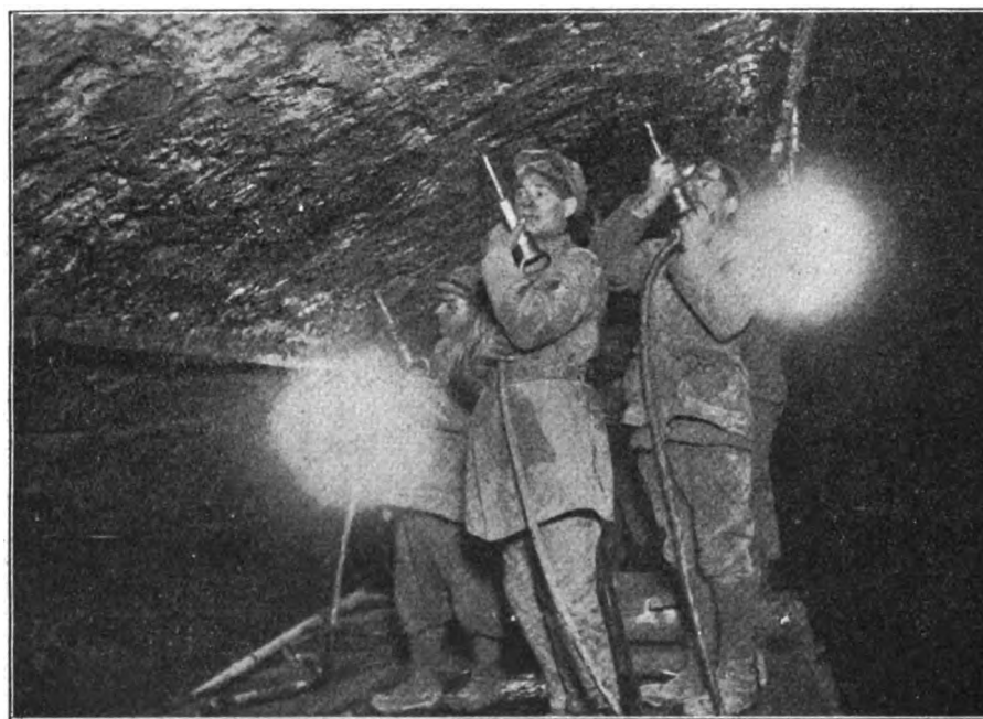
FIG. 7. — Ferrovia Domodossola-Iselle: Pulitura della superficie della volta in conci di pietra nella galleria elicoidale di Varzo con martelli Ingersol, tipo Baby, e utensili a corona dentata.
