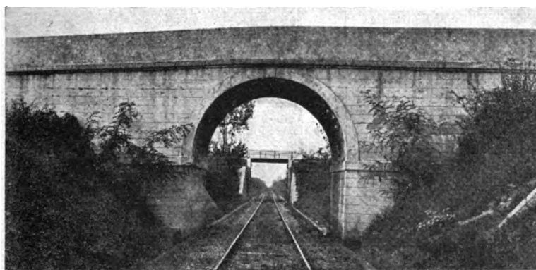
FIG. 15. — Cavalcavia stradale e vista di sottopassaggio ferroviario.
