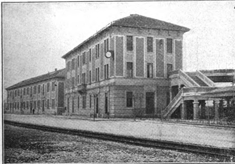
FIG. 21. — Fabbricati uffici, refettorio e spogliatoi lavabi.
