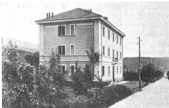
FIG. 25. — Fabbricato alloggi per il personale di servizio addetto alla S. S. E. di Pontremoli.
