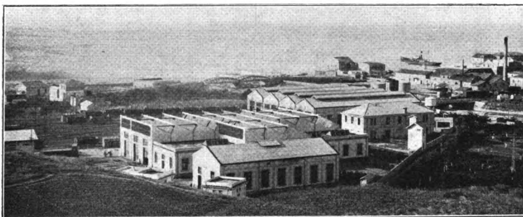
FIG. 1. — Veduta panoramica del nuovo deposito di Catanzaro Marina.
