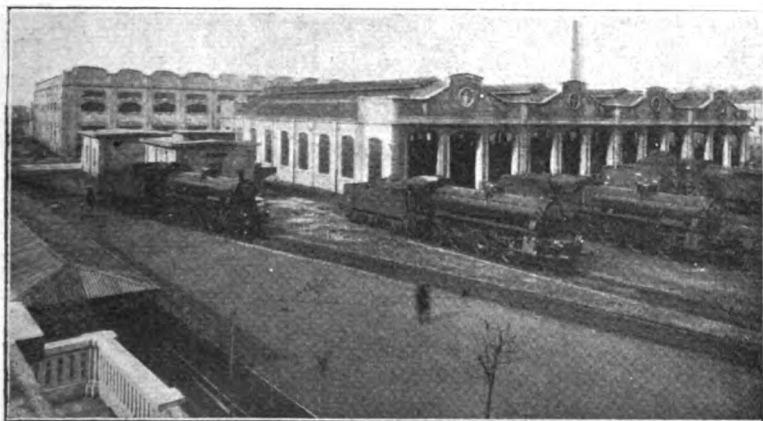
FIG. 17. — Rimessa lato Monza e fabbricato rialzo.
