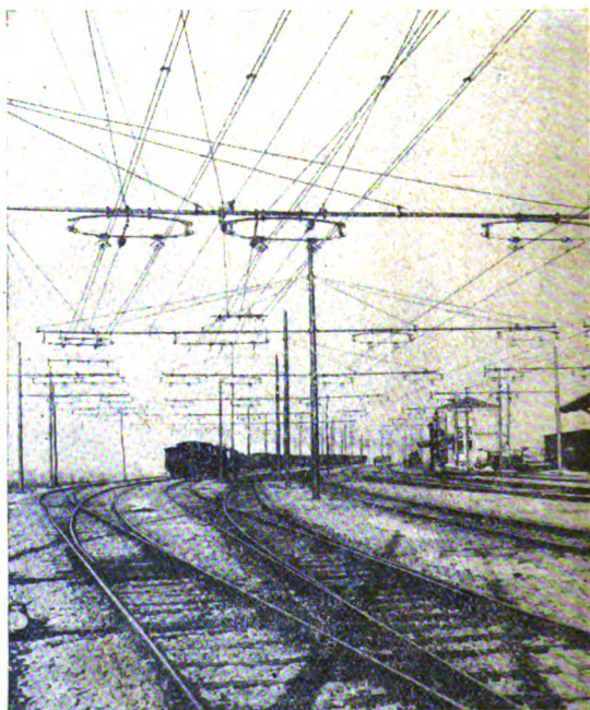
Stazione di Fornovo-Taro condutture di contatto
