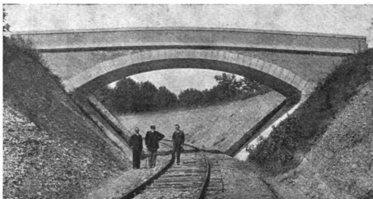
FIG. 13. — Cavalcavia in trincea di Rovato.
