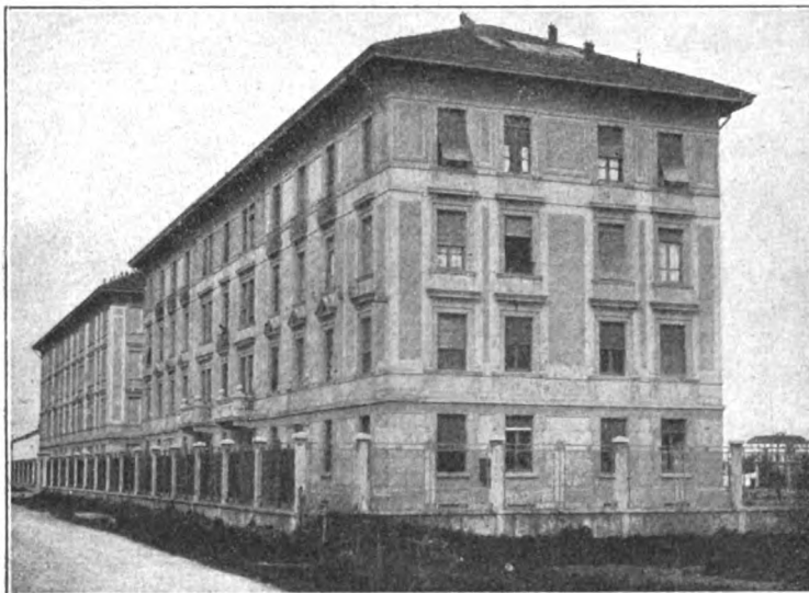
FIG. 22. — Fabbricati alloggi e dormitorio.
