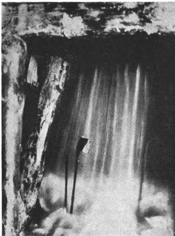
Fig. 1. — Come si presentò all'atto dello scavo la sorgente che ora si intende utilizzare; essa sgorgò improvvisamente dopo una volata di mine alle ore 4,30 del 4 novembre 1927 con una portata di circa 250 l."
