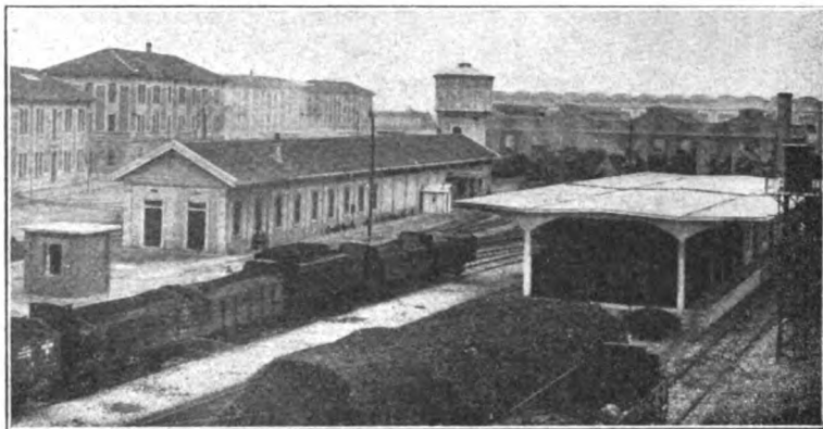
FIG. 16. — Veduta d'insieme del deposito lato Monza.
