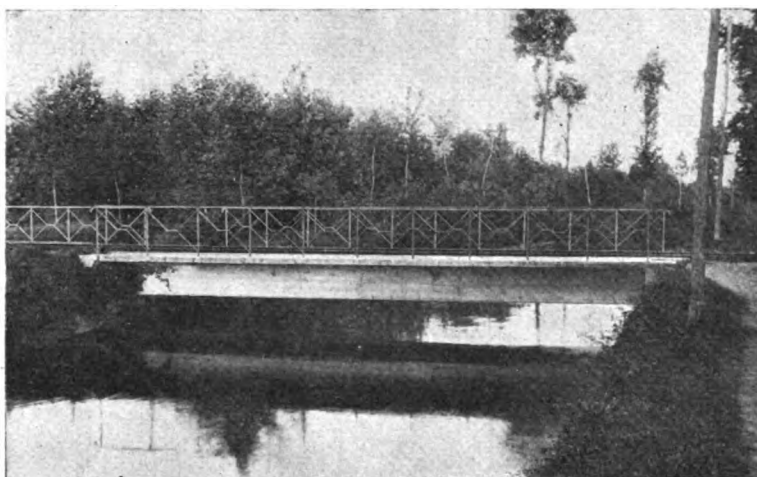
FIG. 14. — Piattabanda di cemento armato.
