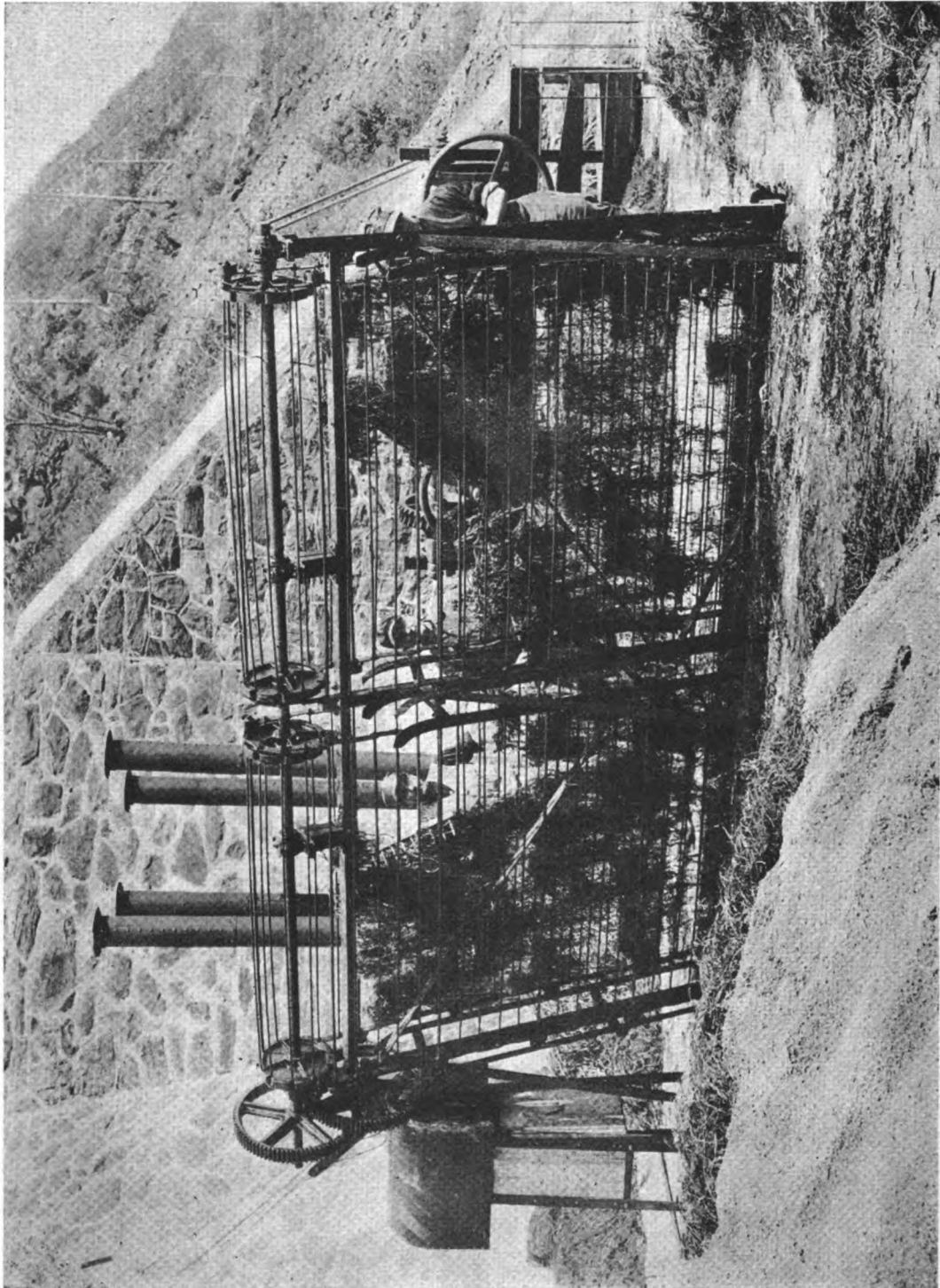
Fig. 3. - Griglia mobile per l'estrazione delle erbe dal colatore « Scivetta » - Vista posteriore.
