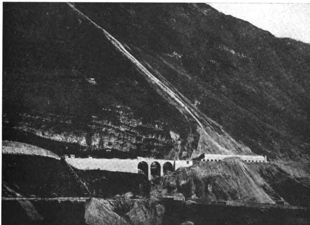
Fig. 5. - Galleria artificiale Barbagiovanni e Viadotto della Lastra a tre luci di m. 12.
