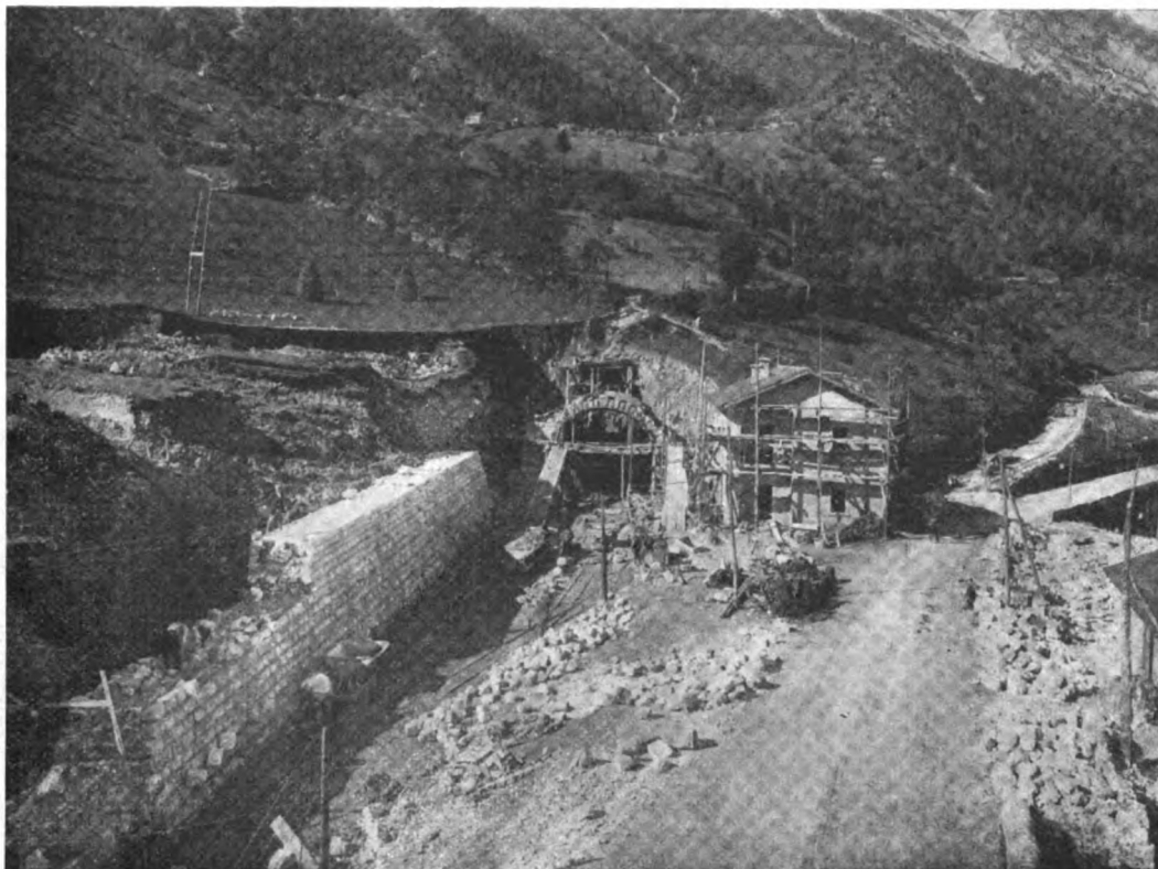
Fig. 12. - Galleria di S. Croce. Costruzione del portale d'imbocco Vittorio, del Muraglione di sostegno a sinistra e della Casa Cantoniera doppia.
