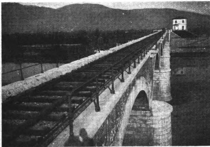
Fig. 2. - Ponte sul fiume Arno con la fermata di Calcinaia Progr. 2987.00
