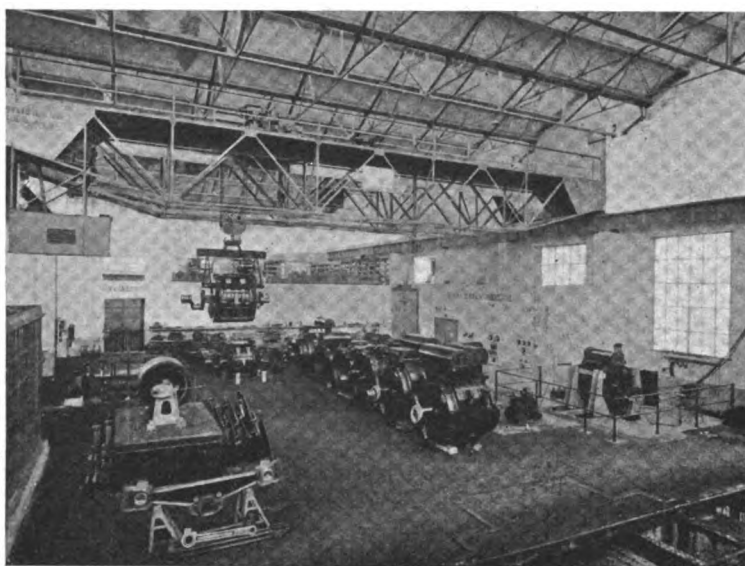
Fig. 10. — Sala riparazione motori e equipaggiamenti elettrici.
