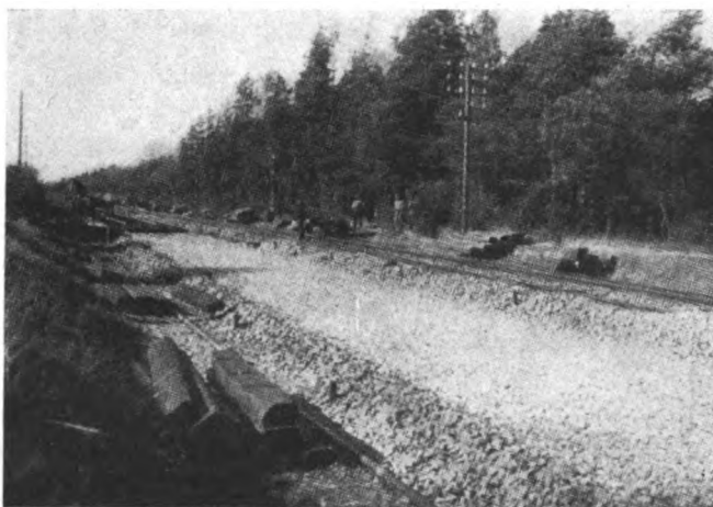
Fig. 2. — Piano di posa sistemato.
