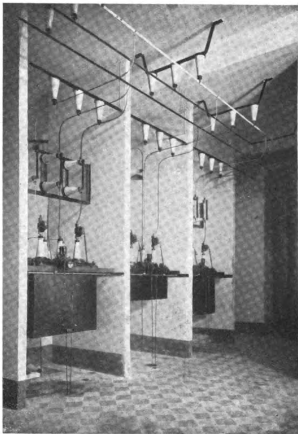
Fig. 14. — Interruttore principale nel mezzo e interruttori di macchina ai lati.
