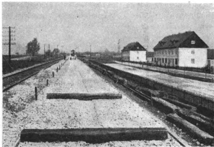
Fig. 4. — Piano di posa sistemato. (A destra e a sinistra i picchetti per la livellazione).
