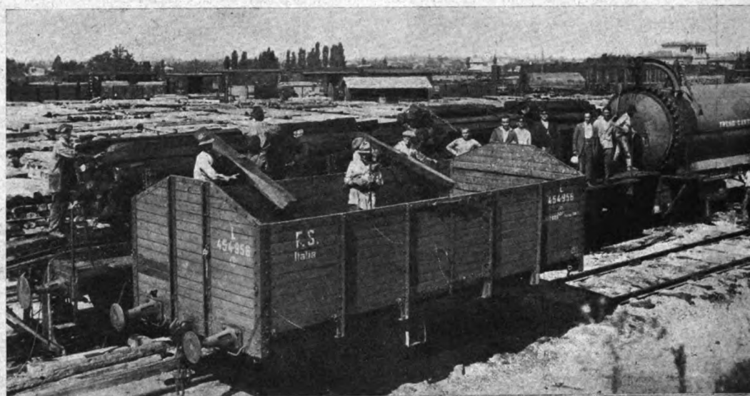
Fig. 9. — Il carico delle traverse iniettate sui carri ferroviari.
