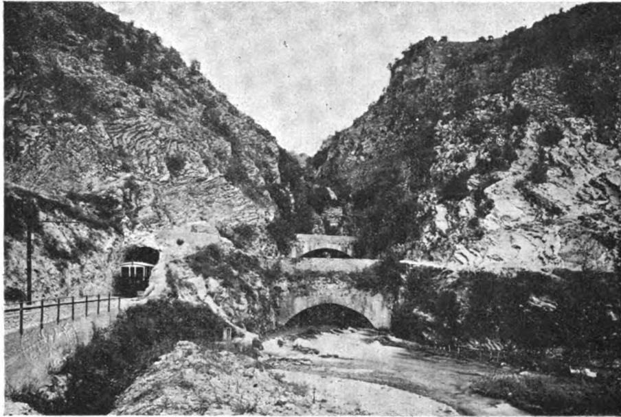
Imbocco « Nord » della Galleria di Biselli (Km 42).
