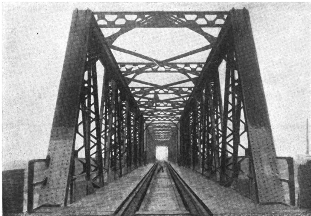
Fig. 8. — Nuove travate sul Reno presso Lavezzola.
