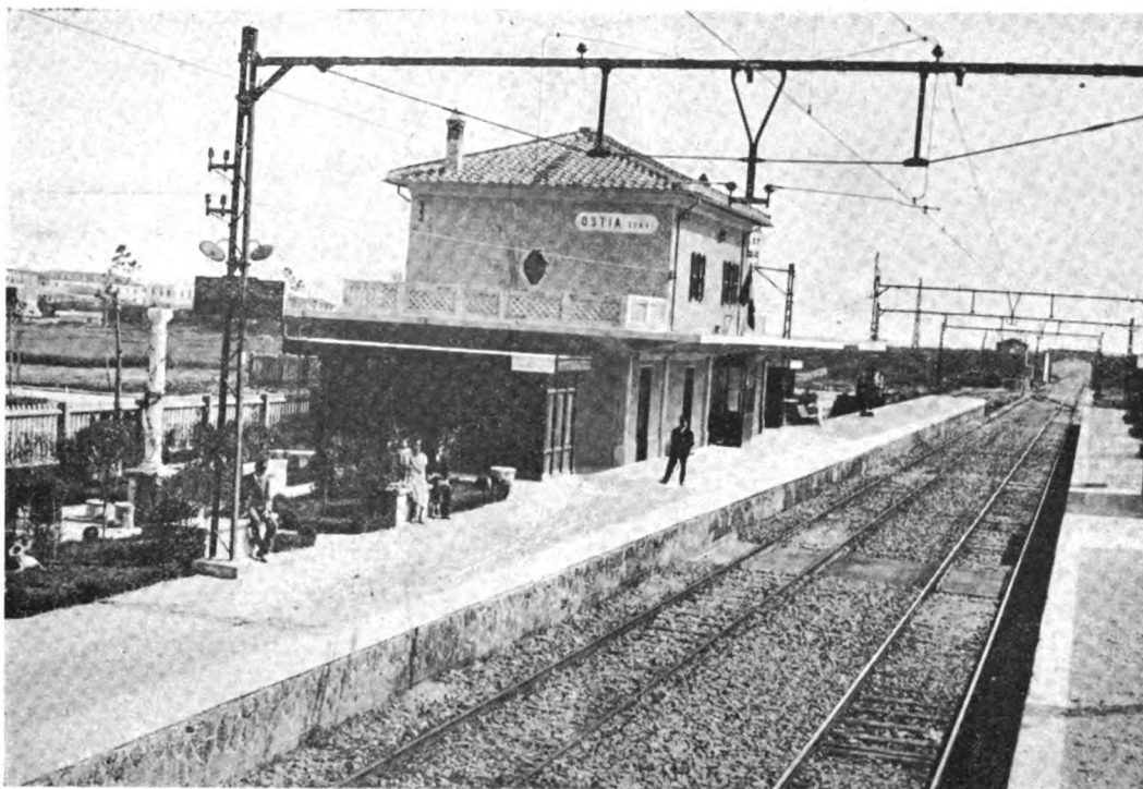
Fig. 3. — Stazione di Ostia scavi.
