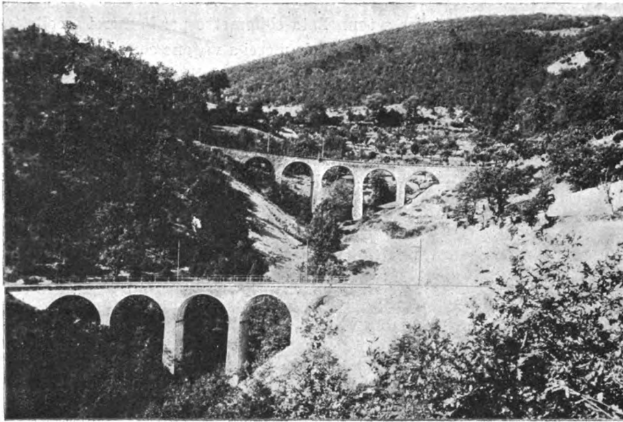
Viadotti di Torre (Km 12,3 e 13.1)
