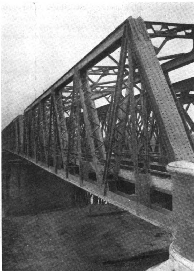
Fig. 7. — Nuove travate sul Reno presso Lavezzola.
