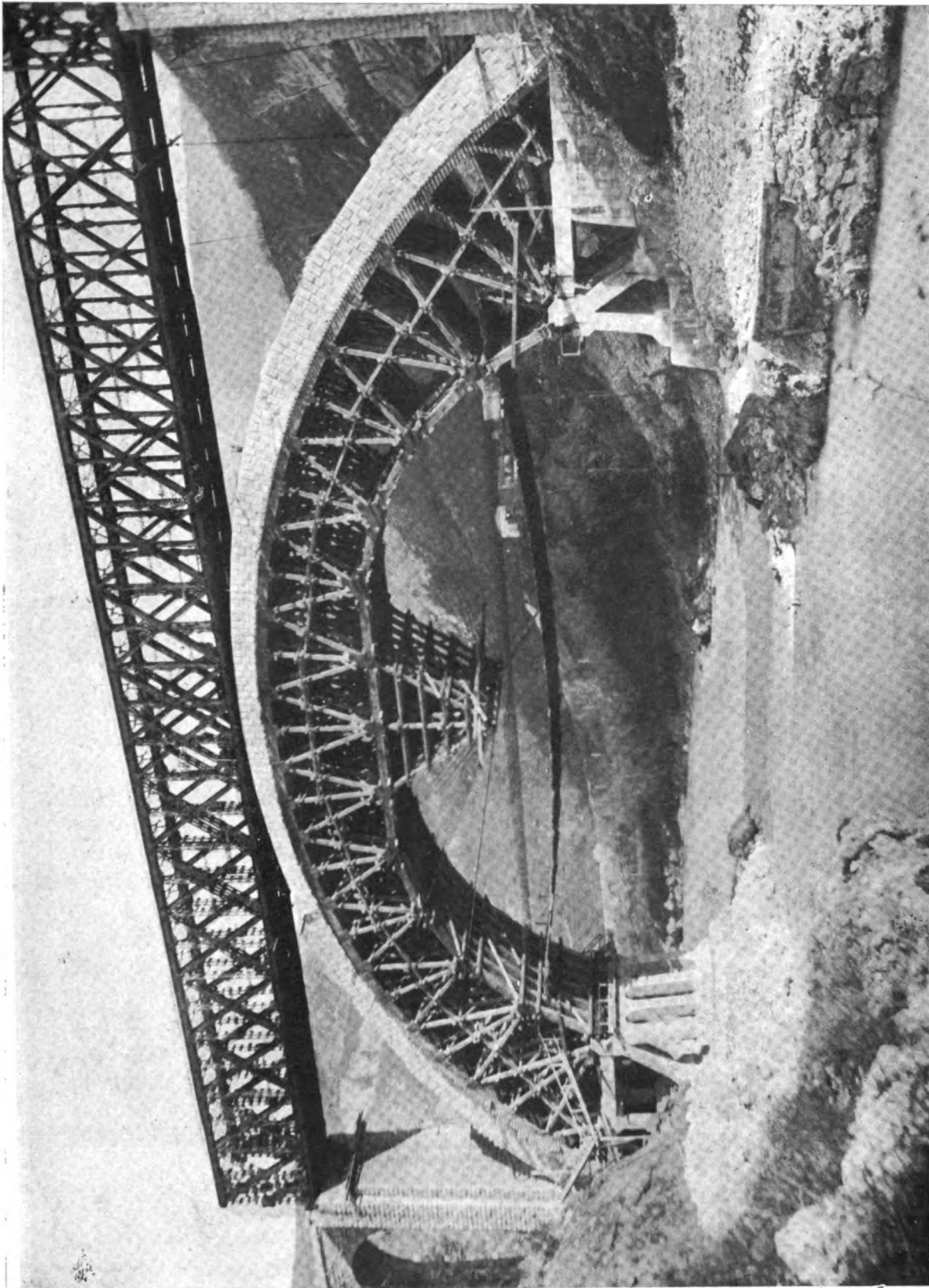
Fig. 3. — Fonte di Salcano. Ricostruzione della grande arcata dell'ampiezza di m. 85.
