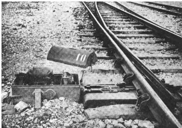
Fig. 11. — Motorino e timoneria di uno scambio.
