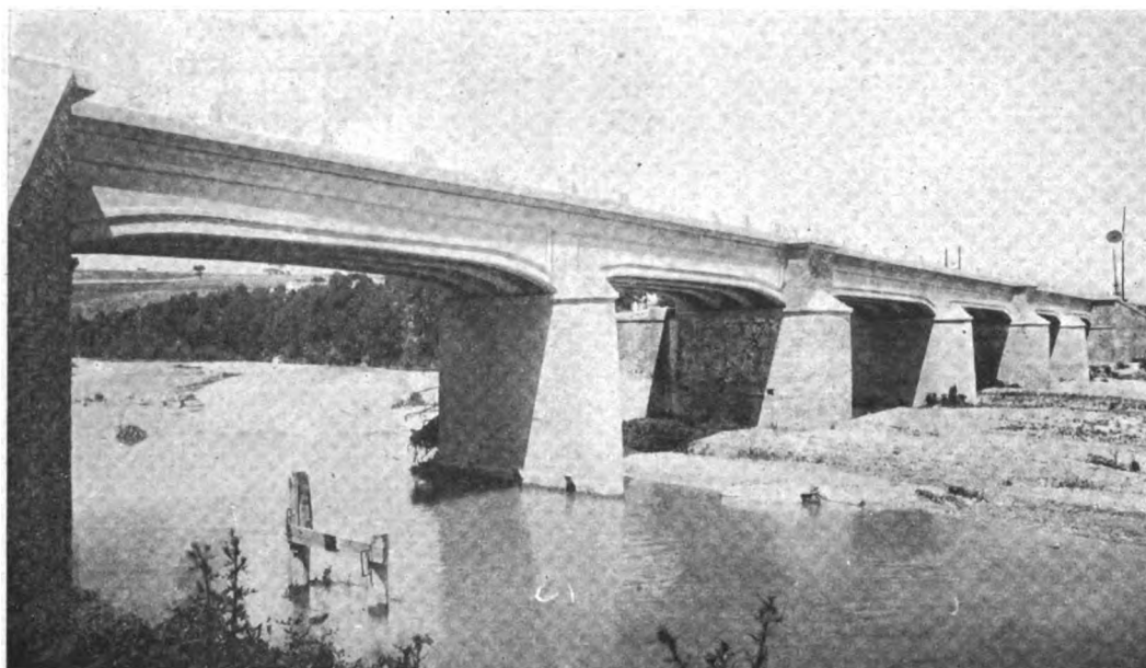
Fig. 3. — Ponte sul Potenza.
