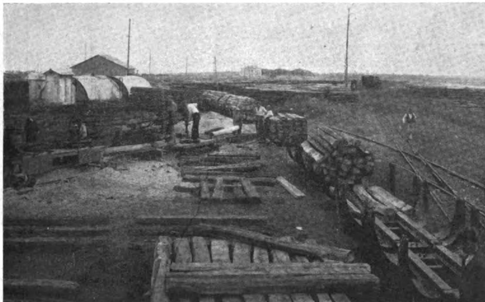
Fig. 26. - La lavorazione delle traverse (spianatura a foratura).
