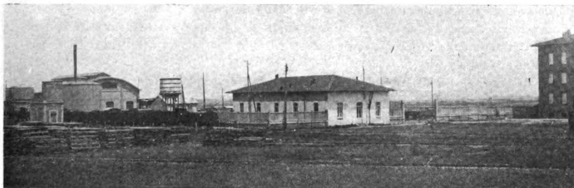
Fig. 16. — L'ingresso al Cantiere. Il Fabbricato Uffici.
