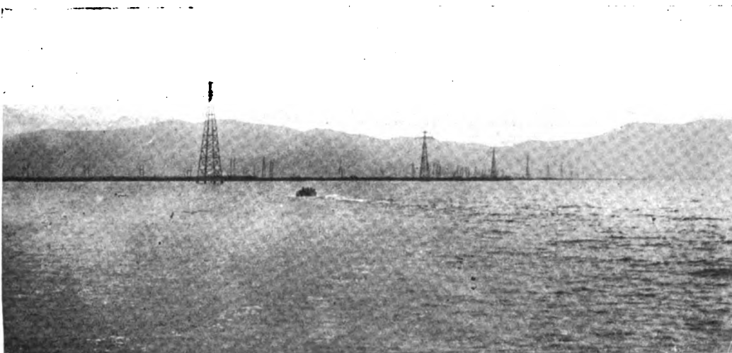
Fig. 19. — Veduta generale dell'attraversamento.
