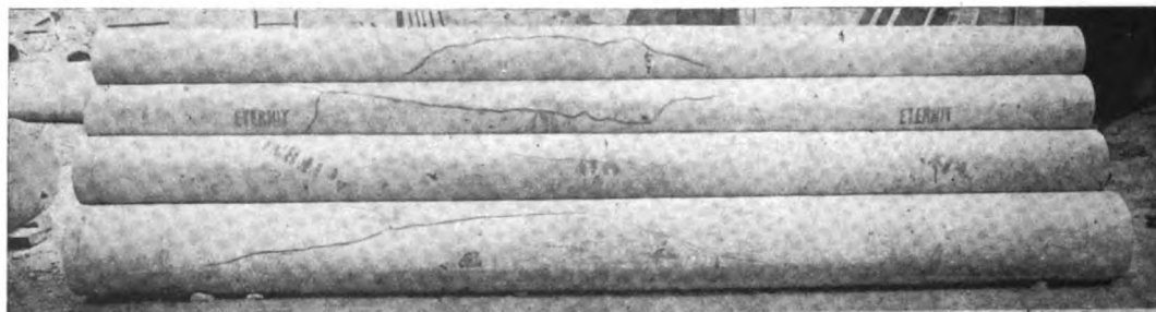
Fig. 3. — Tubi rotti per pressione idraulica.
