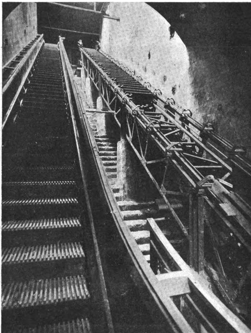
Fig. 3. — Fermata di piazza Cavour. - Montaggio delle scale del rampante inferiore ricadente in alto nel pozzo di aerazione e di illuminazione. Le mensole della balaustrata della scala a destra sono attraversate, nella parte centrale, da un canale di legno, che serve a raccogliere ed a guidare il corrimano mobile nella sua corsa di ritorno.
