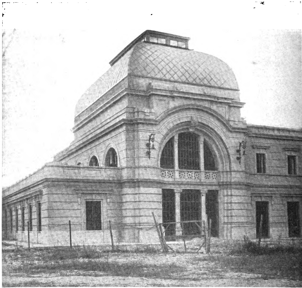
Fig. 5. — Stazione di Verona P. N. — Nuovo fabbricato viaggiatori. Fianco lato verso Venezia.
