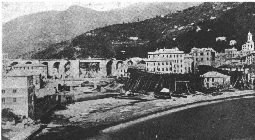
Fig 1. — Il viadotto a semplice binario durante la sua costruzione (1865). Prospetto a mare.
