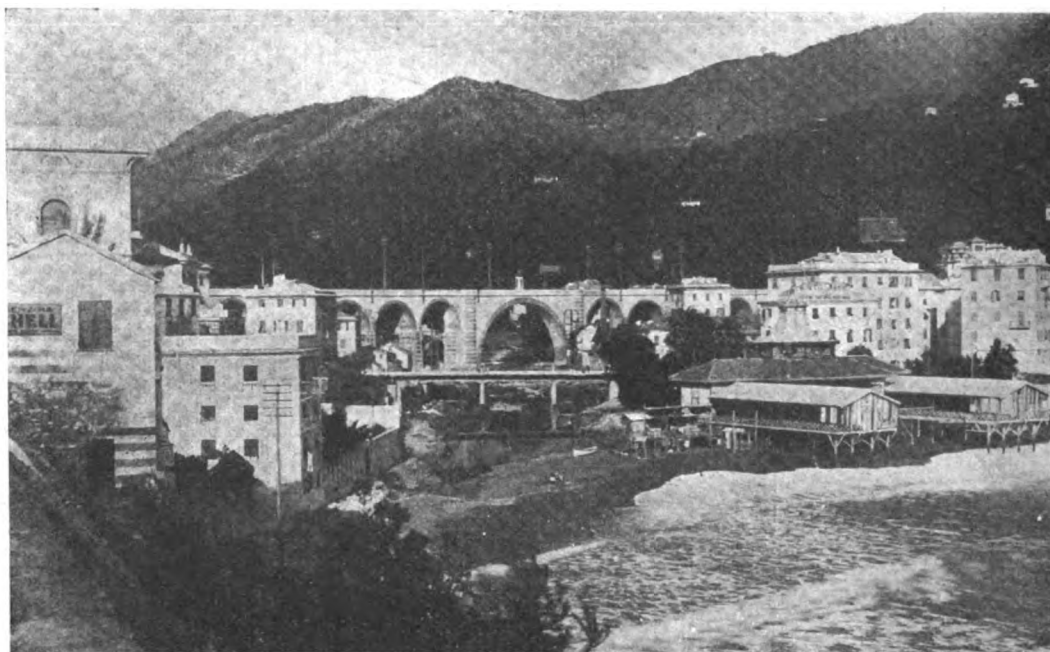
Fig. 2. — Il viadotto a tre binari dopo i lavori di sistemazione (1923). Prospetto a mare.
