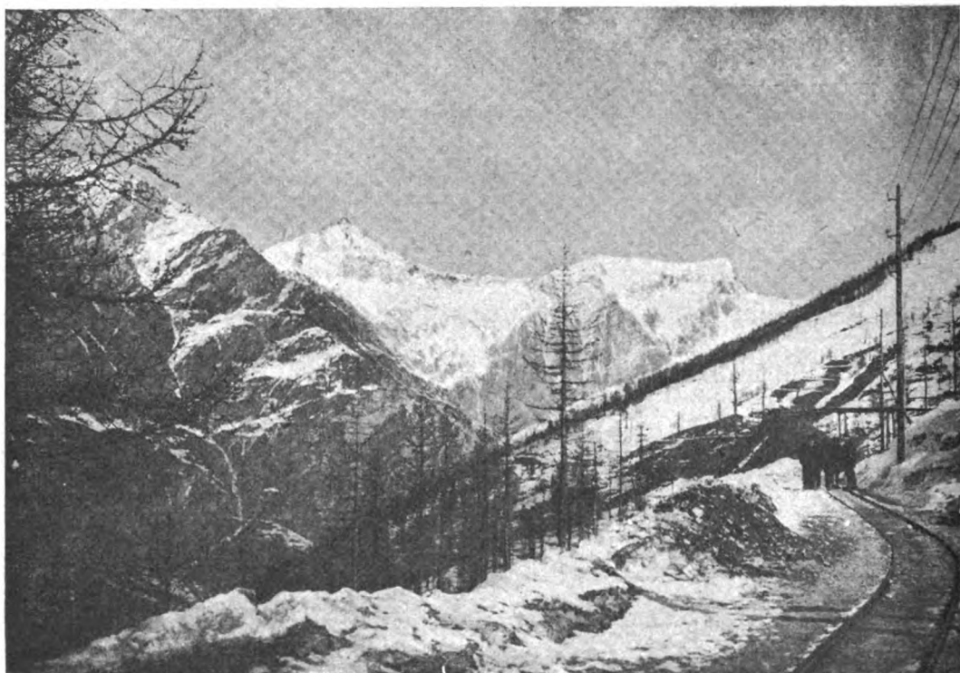
Fig. 13. — Impianto idroelettrico del Rochemolles, linea Decauville di servizio lungo il canale.
