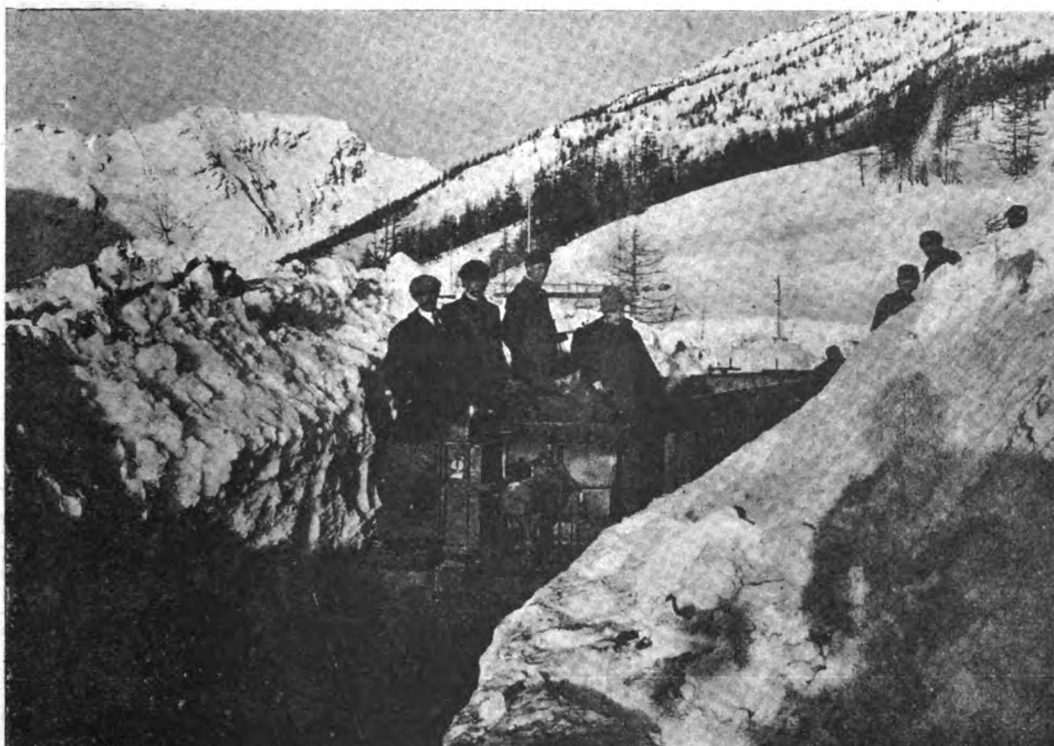
Fig. 14. — Impianto idroelettrico del Rochemolles: Trenino di servizio lungo la ferrovia Decauville fiancheggiante il canale, locomotiva a benzina da 40 HP
