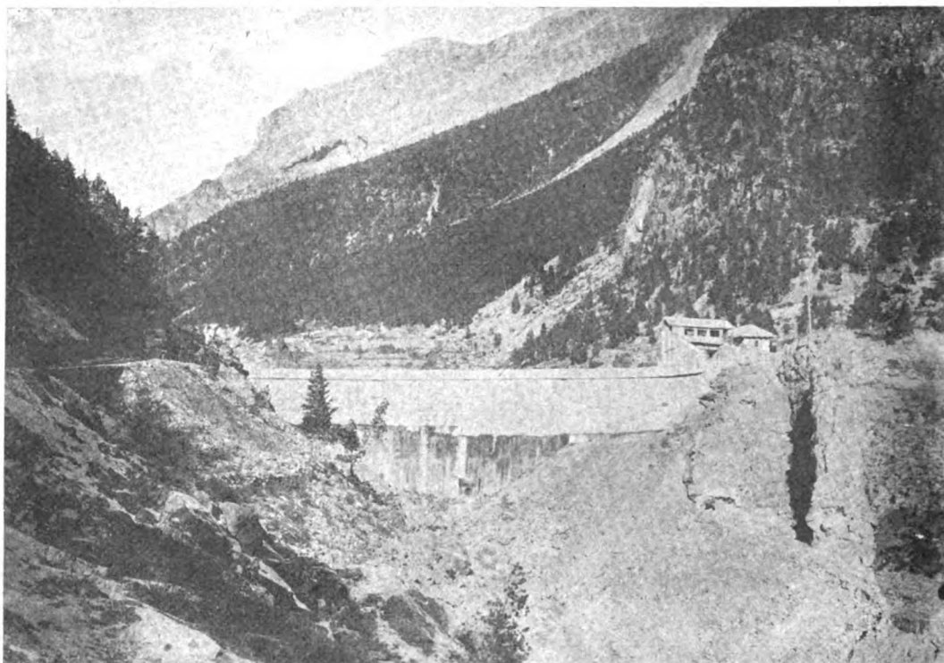
Fig. 2. — Diga di presa vista da valle.
