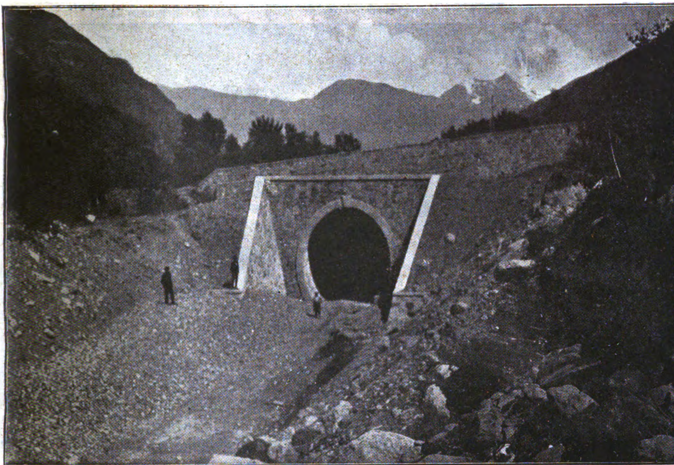
Fig. 4. - Galleria subalvea del torrente Arlier - Imbocco Aosta.
