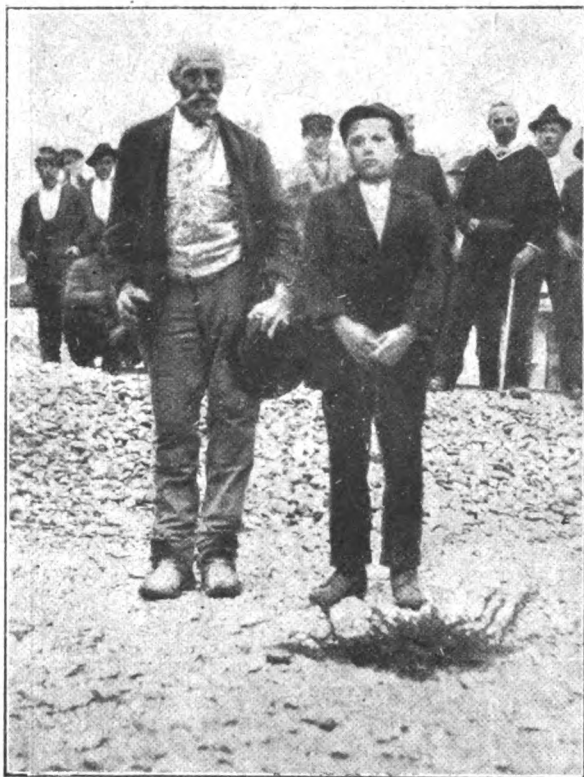
Fig. 11. - I due viadotti nelle loro maestranze: Il garzone più giovane e il decano del cantiere del nuovo viadotto costruito durante l'ultima guerra, che, profugo trentino, fu già garzone nel cantiere del vecchio viadotto costruito durante la guerra del 1866.
