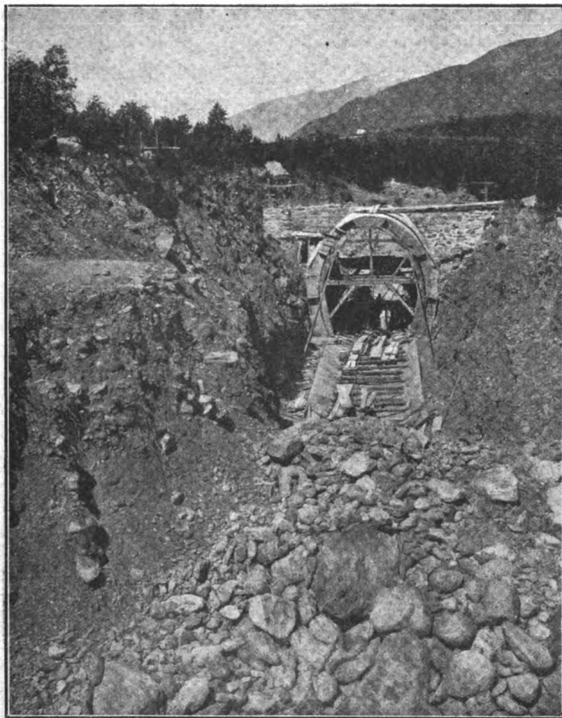
Fot. 8ª - VEDUTA DELLA TRINCEA ATTRAVERSO IL DEPOSITO CAOTICO DELLA CONOIDE DI DEJEZIONE DELL'ARLIER, ESEGUITA PER LA COSTRUZIONE DEL SOTTERRANEO SUB-ALVEO
