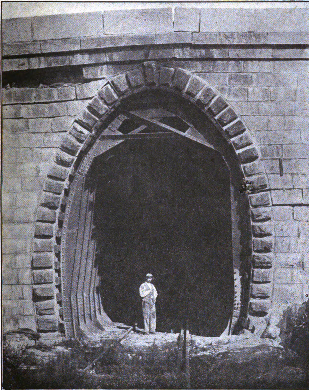
Fig. 1. - Imbocco Aosta della galleria di Tercy (Fot. settembre 1920).
