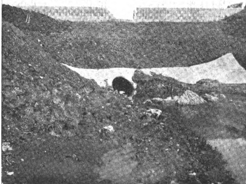
Fig. 3 — Diga di terra e diaframma in blocchetti di cemento durante la costruzione
