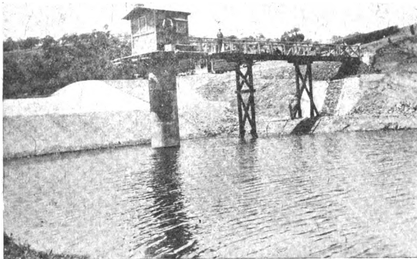
Fig. 8 — Passerella e torretta di manovra nella quale si trovano gli apparecchi autoregistratori per le osservazioni meteorologiche.
