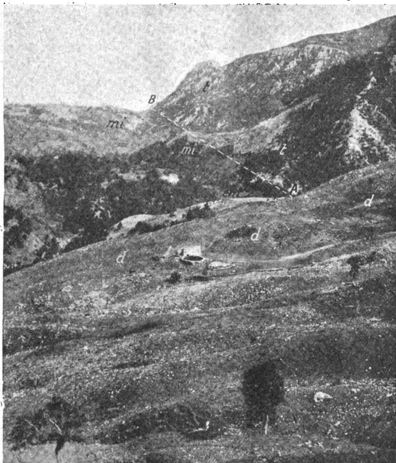
Fot. 1 — Veduta del tracciato della galleria dell'acquedotto dalle sorgenti Fra Paolo alla Sella di Petralia. t = dolomia. mi = arenaria quarzosa. em = argille coceniche. d = detrito di falda. A-B = tracciato della galleria. A = punto in vicinanza delle sorgenti Fra Paolo.
