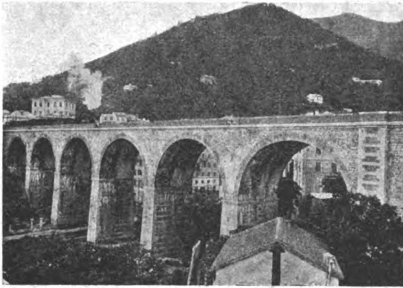
Viadotto di Bogliasco.
