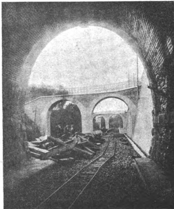
Cavalcavia privati Crosa e Walti a due luci in calcestruzzo cementizio.
