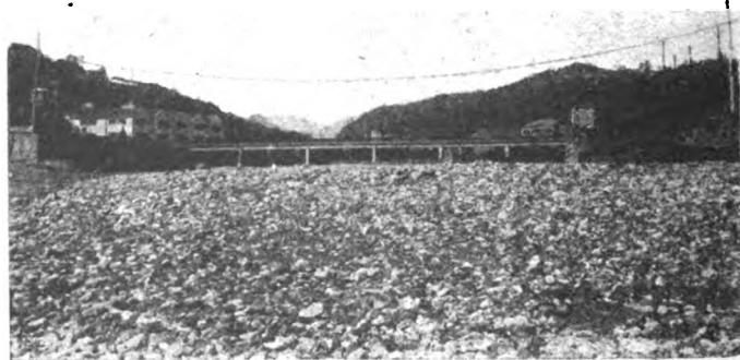
Fig. 2. — Traversata del Polcevera (m. 90) con cavi aerei per l'allacciamento della stazione di S. Quirico.
