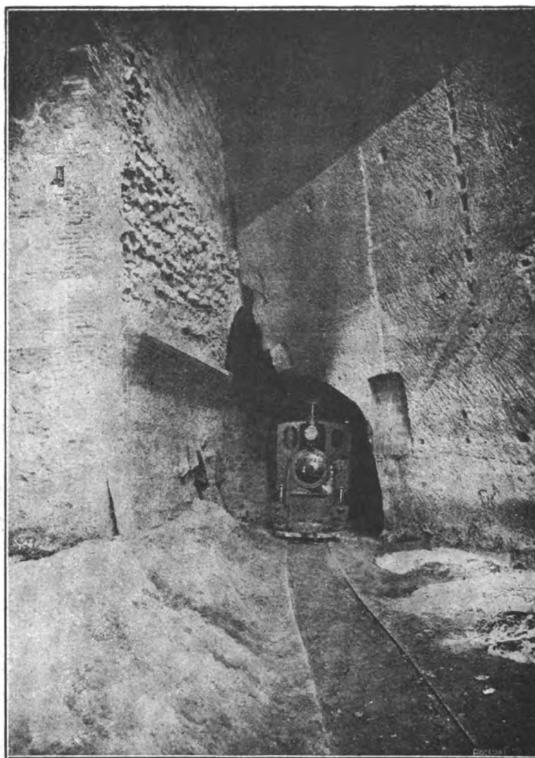
Fig. 18. — Piedritto destro della galleria, nel tratto compreso tra quelli con calotta sopralzata, in corrispondenza d'uno dei piloni da asportare.
