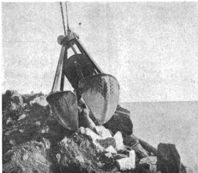
Fig. 13. — Benna automatica, scavando vecchia scogliera.
