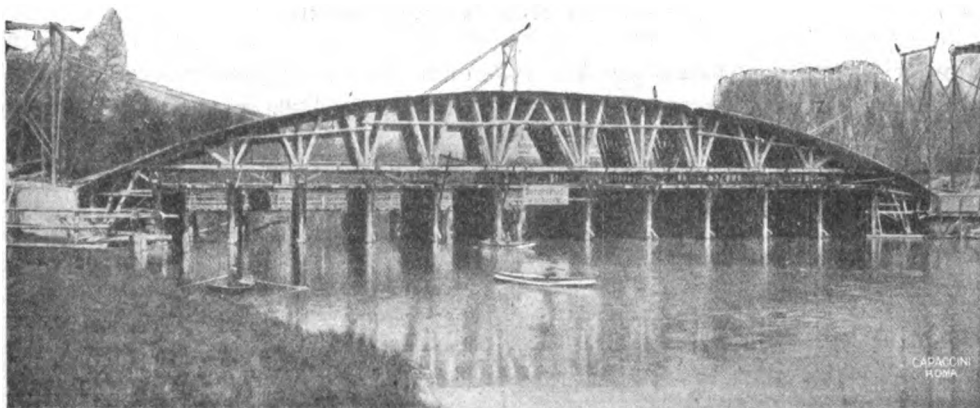
Fig. 5. — Centina dell'arco centrale.
