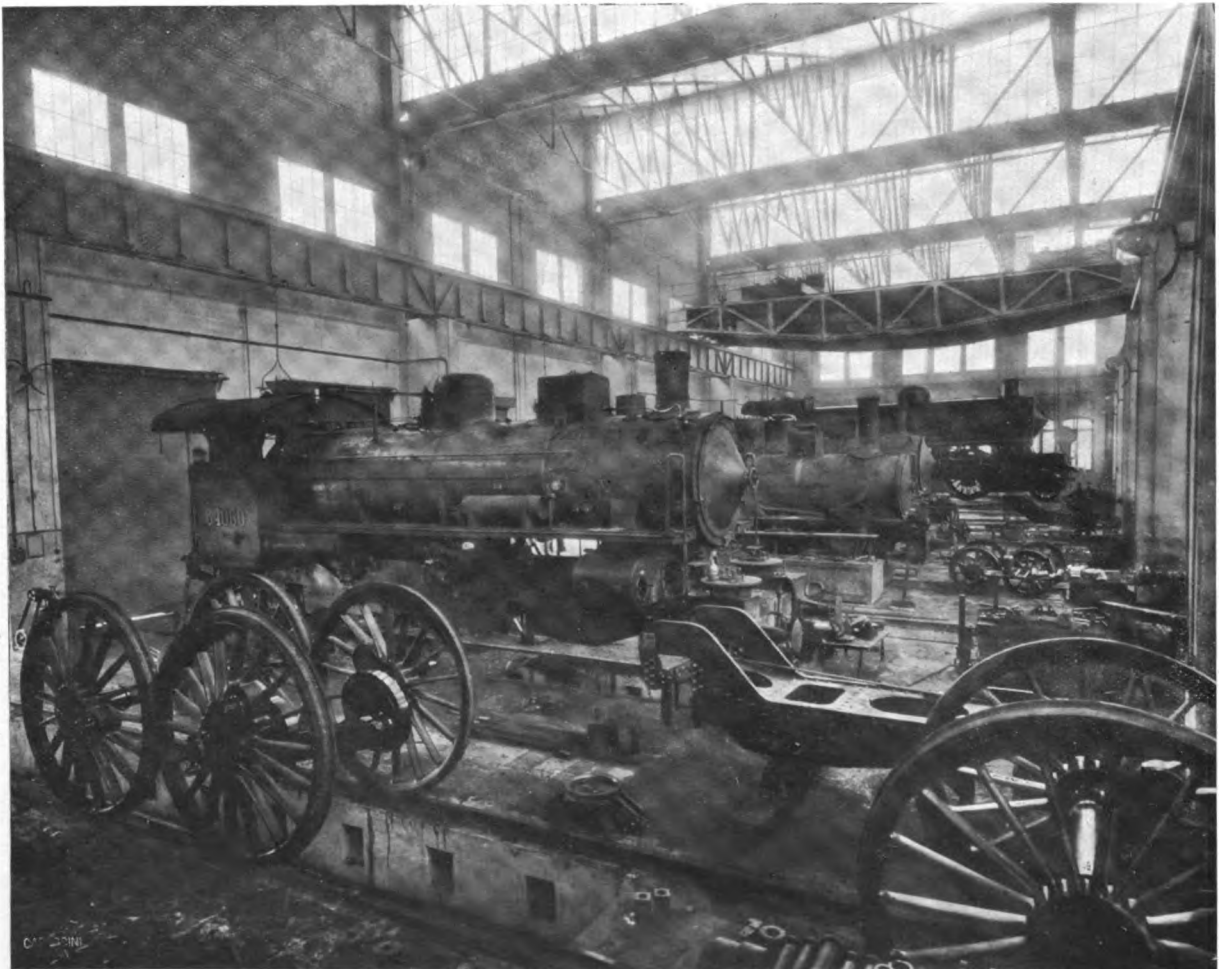
Deposito locomotive di Mestre. Corsia del montaggio (gru da 80 tonn.).
