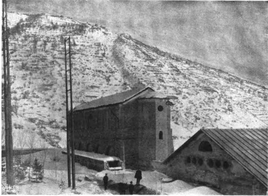
c) Pali doppi per ormeggio delle primarie all'arrivo a Bardonecchia e locali dei vecchi compressori Sommeiler, come erano prima del lavoro di adattamento per gli impianti di T. E.
