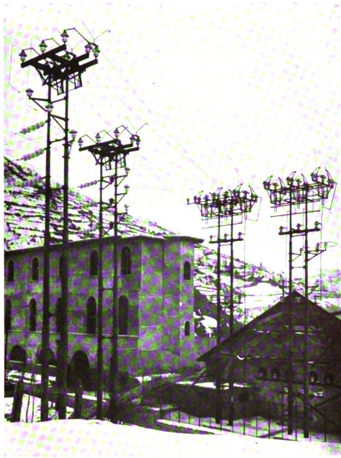
a) Gruppo degli interruttori aerei a 55000 Volts all'arrivo delle primarie alla sottostazione di Bardonecchia e locali interruttori e trasformatori 55000 V 16 per. (a sinistra), a destra entrata linee 55000 V.
