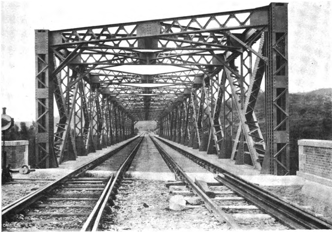
Travata nuova ultimata.
