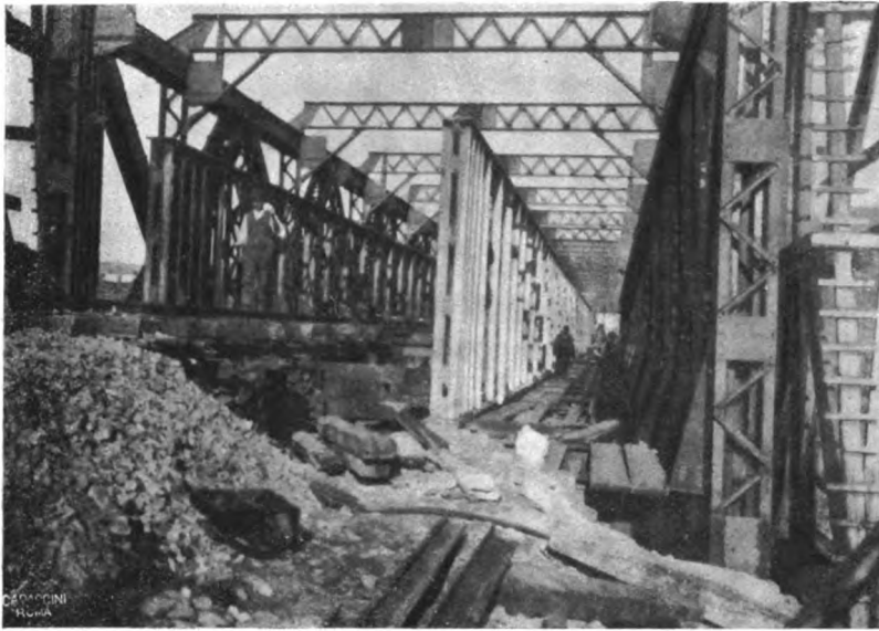
Dopo spostata lateralmente la vecchia travata e prima di asportare la trave principale a monte della travata medesima.
