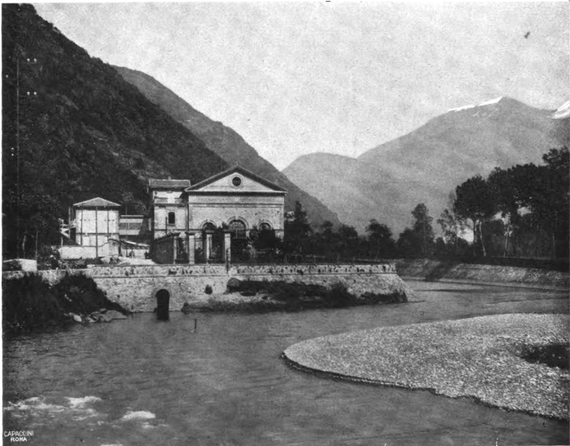
q) Centrale di Morbegno. A sinistra la nuova cabina per lo smistamento e protezione delle terne primarie.
