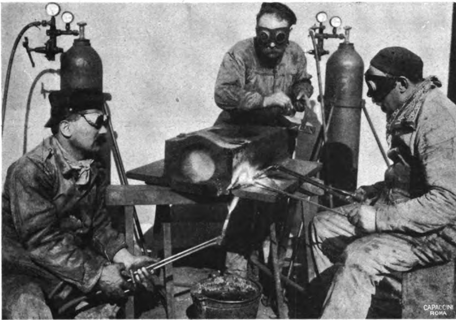
Fig. 29. — Riparazione di un blocco per carrello di loc. Gr. 530. Durante la saldatura.
