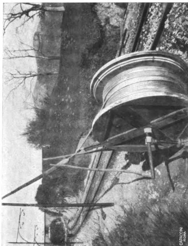
Fig. 2. — Bobina sui cavalletti in attesa di essere tirata sul filo di guardia.
