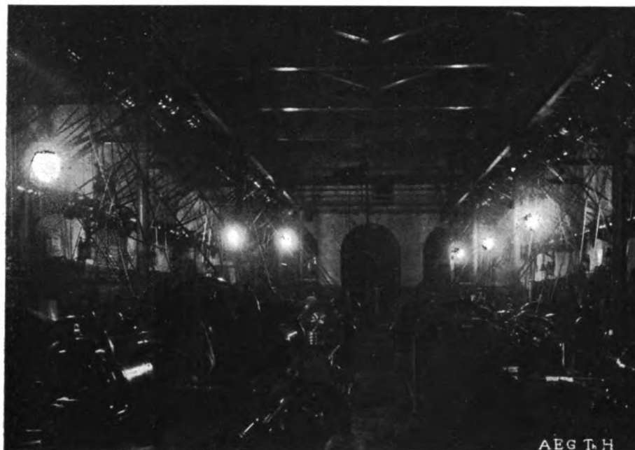
Fig. 6. — Officine di Firenze: Illuminazione Torneria.
