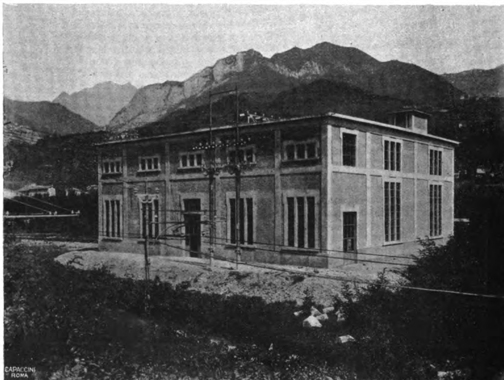
Fig. 4. — Sottostazione di Calolzio.
