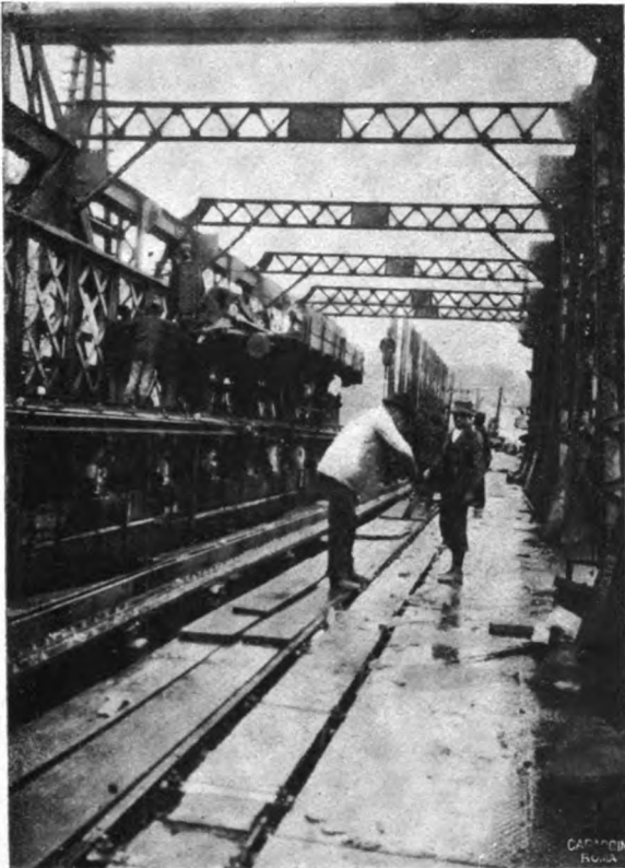
Durante il taglio dei traversi della vecchia travata e la smontatura della trave principale a monte.
